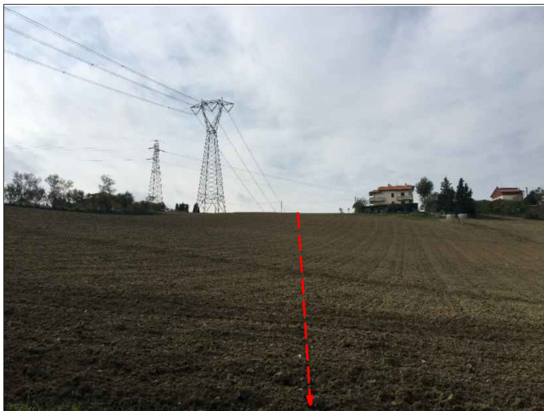
Percorrenza del tracciato in prossimita' della S.P. n.39, in Comune di Gradara
