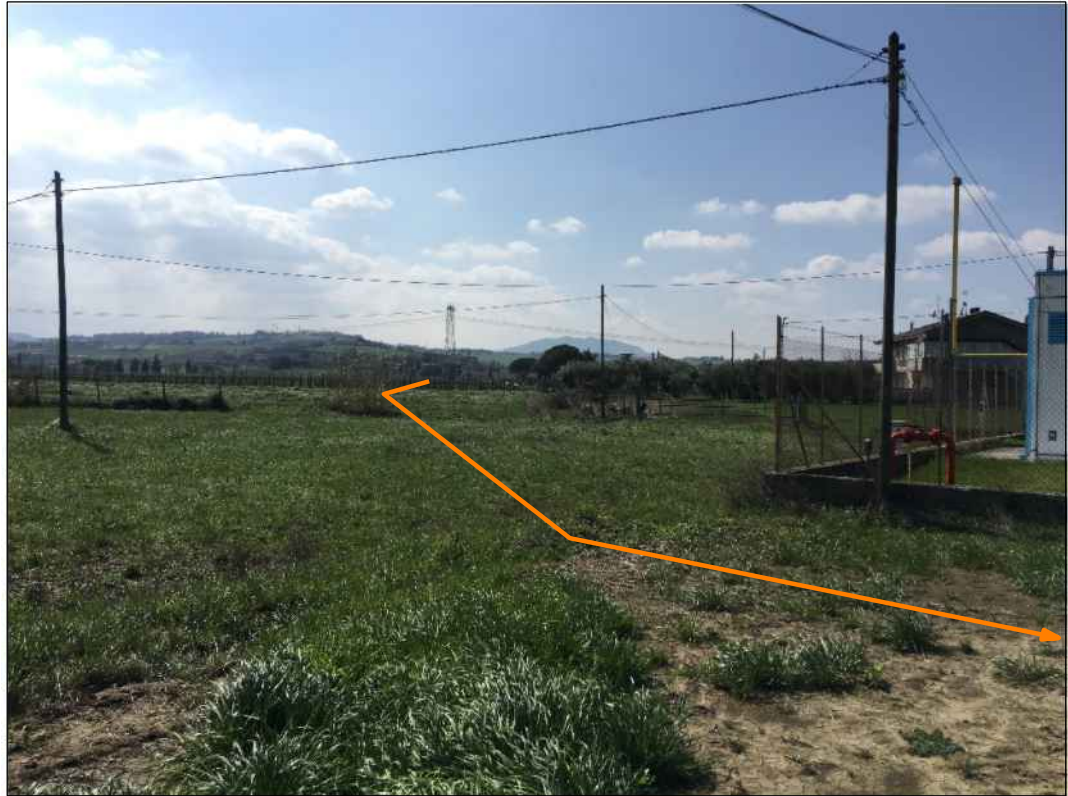
Panoramica del tracciato, in prossimita' della Frazione Gaiofana del Comune di Rimini
