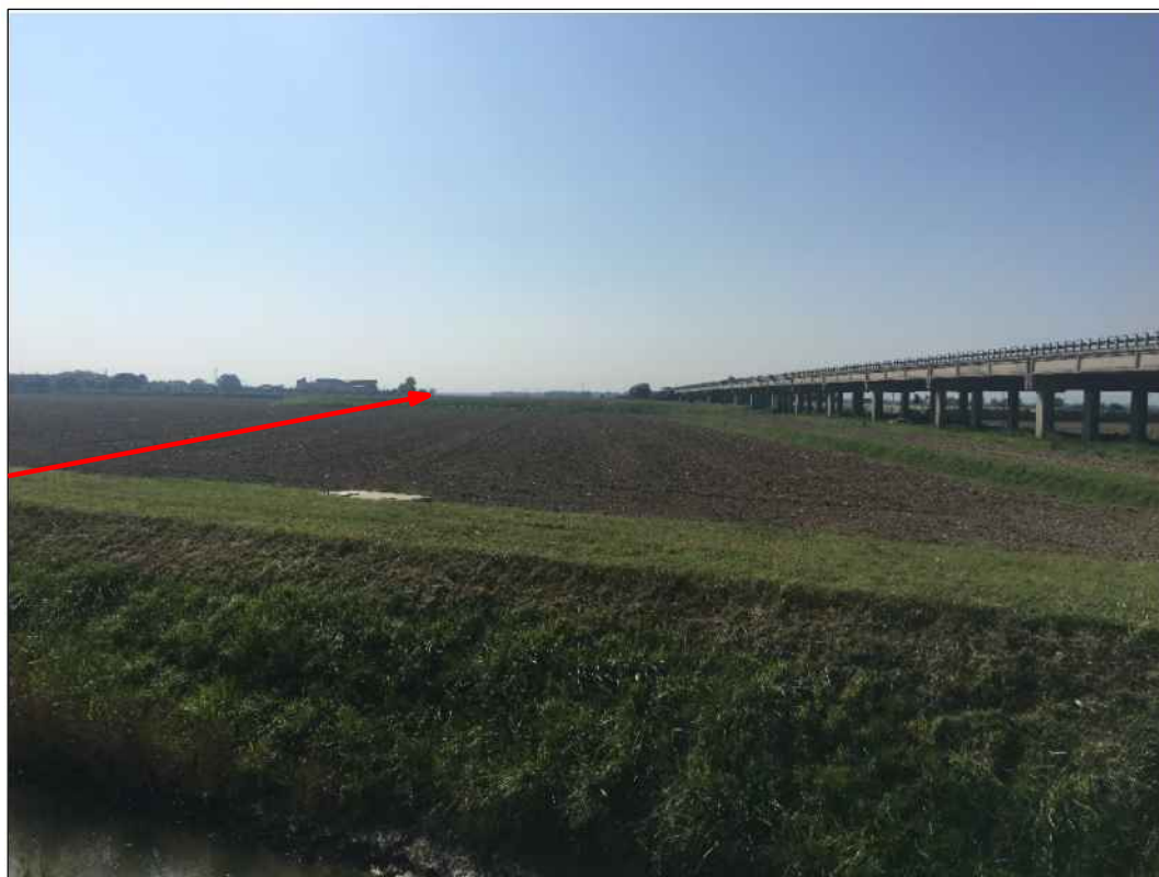
Attraversamento del Canale del Molino in prossimita' della E45, in Comune di Ravenna
