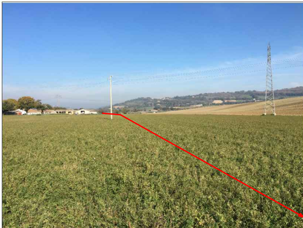
Percorrenza di prati della condotta, in Comune di Gradara
