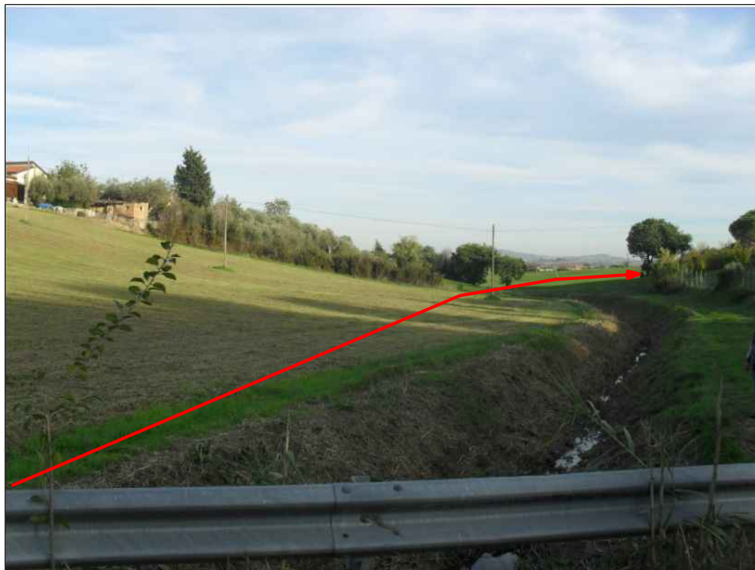
Percorrenza della condotta lungo il Rio de Castellaro, in Comune di Misano Adriatico
