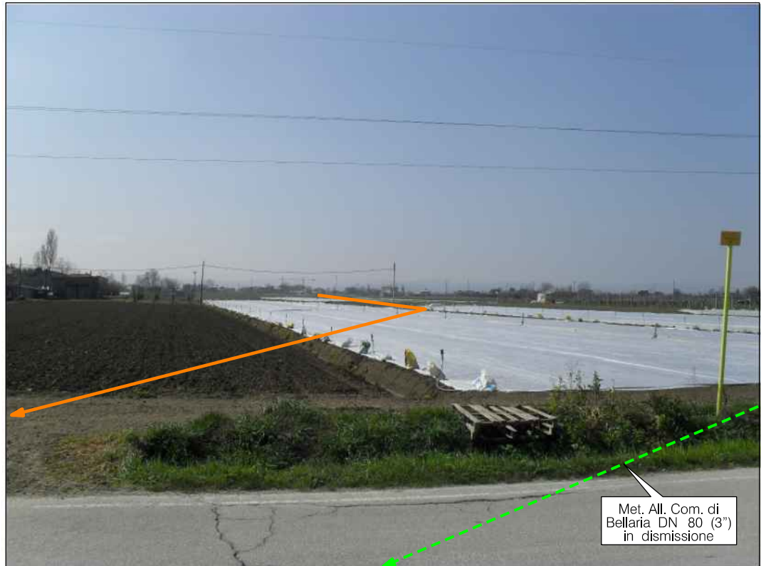
Percorrenza della condotta in appezzamenti a seminativo in prossimita' della S.P. 13 bis, in Comune di Bellaria-Igea Marina
