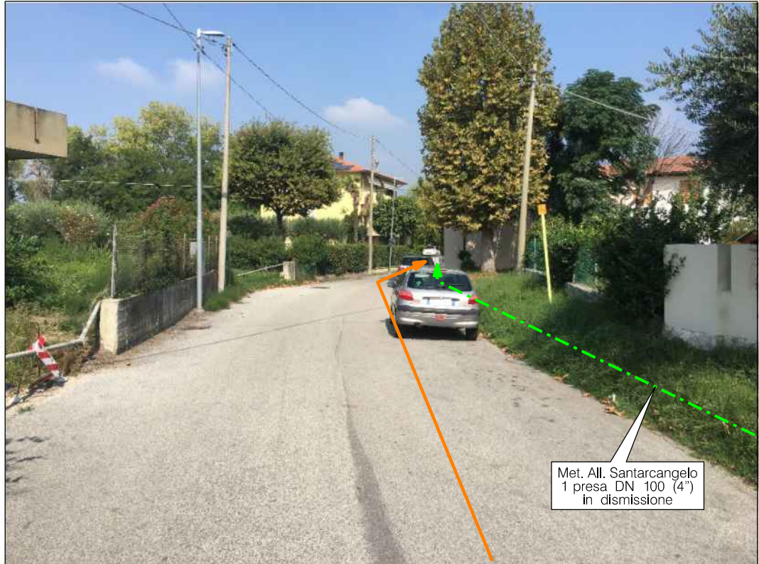
Percorrenza su strada della condotta in localita' San Vito in Comune di Santarcangelo di Romagna
