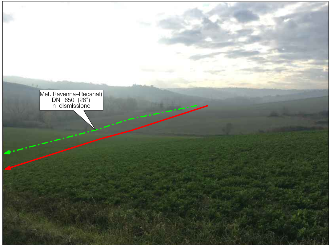
Panoramica della condotta in seminativi in prossimita' del Rio del Roveto, in Comune di San Costanzo
