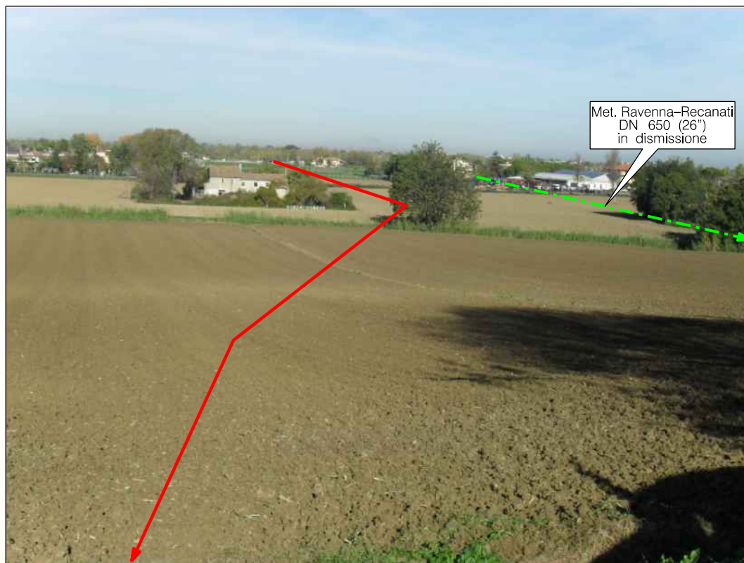
Percorrenza della condotta in seminativi in prossimita' del Fosso Mavone, in Comune di Rimini
