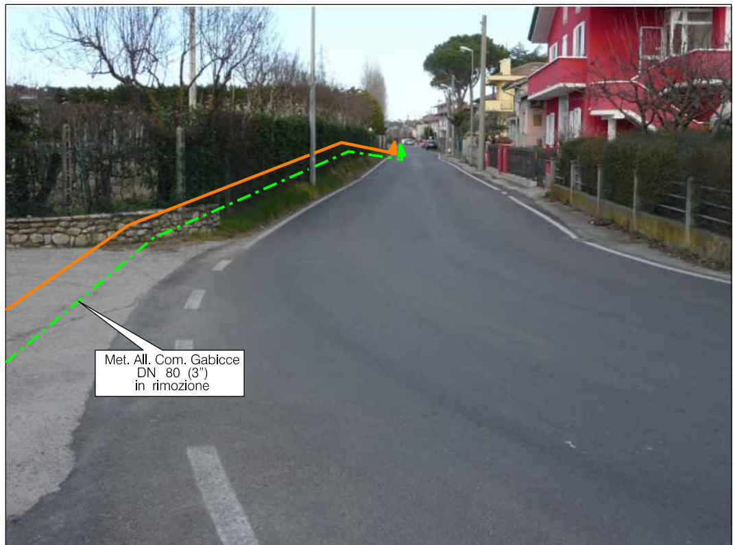
Panoramica del tracciato su strada comunale "via Toscanini" in Comune Cattolica
