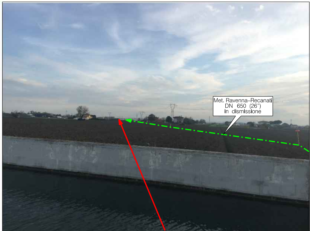
Attraversamento del Canale Emiliano Romagnolo, in Comune di San Mauro Pascoli
