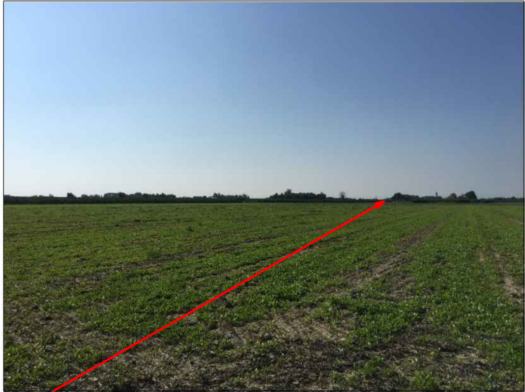
Panoramica del punto iniziale della condotta in Comune di Ravenna
