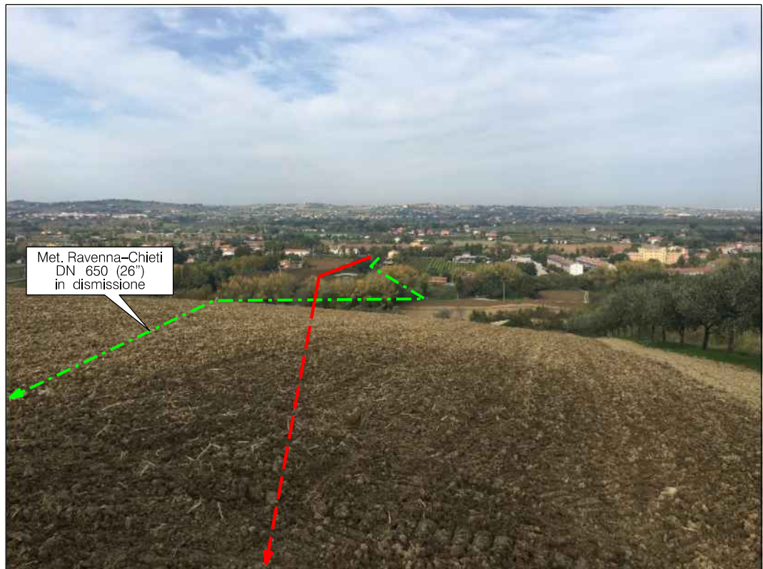
Attraversamento della condotta in seminativi in T.O.C., in Comune di San Giovanni in Marignano
