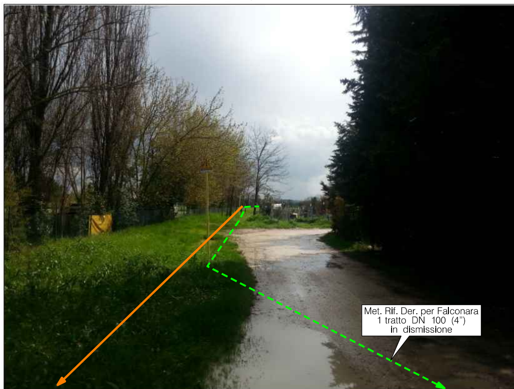
Panoramica del tracciato in prossimita' del Fiume Esino, in Comune di Chiaravalle
