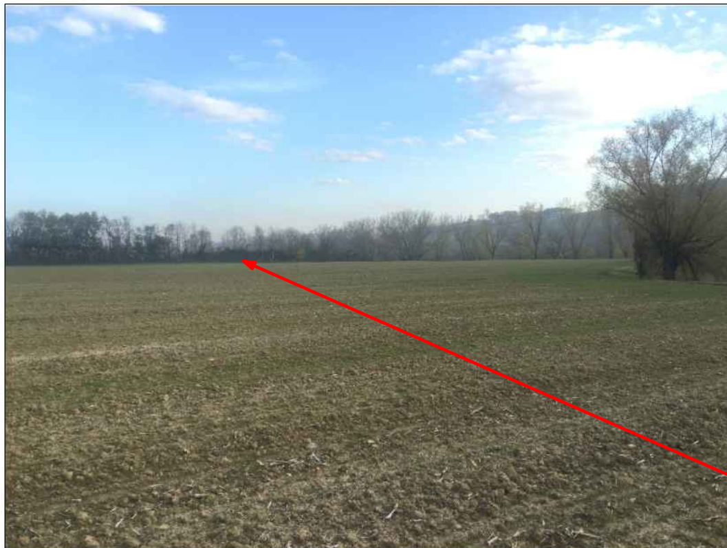
Panoramica della condotta in seminati in prossimita' del Rio Maggiore, in Comune di San Costanzo
