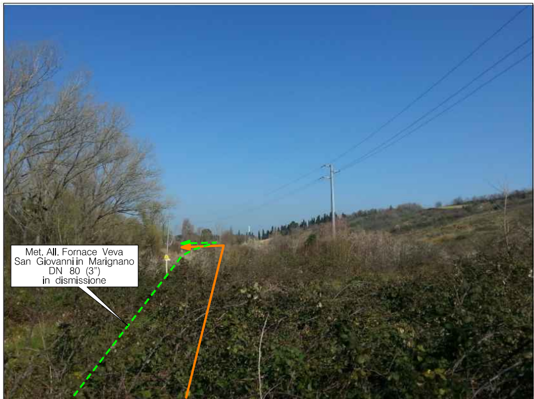
Percorrenza della condotta in area ripariale in prossimita' del Torrente Ventena, in Comune di San Giovanni in Marignano
