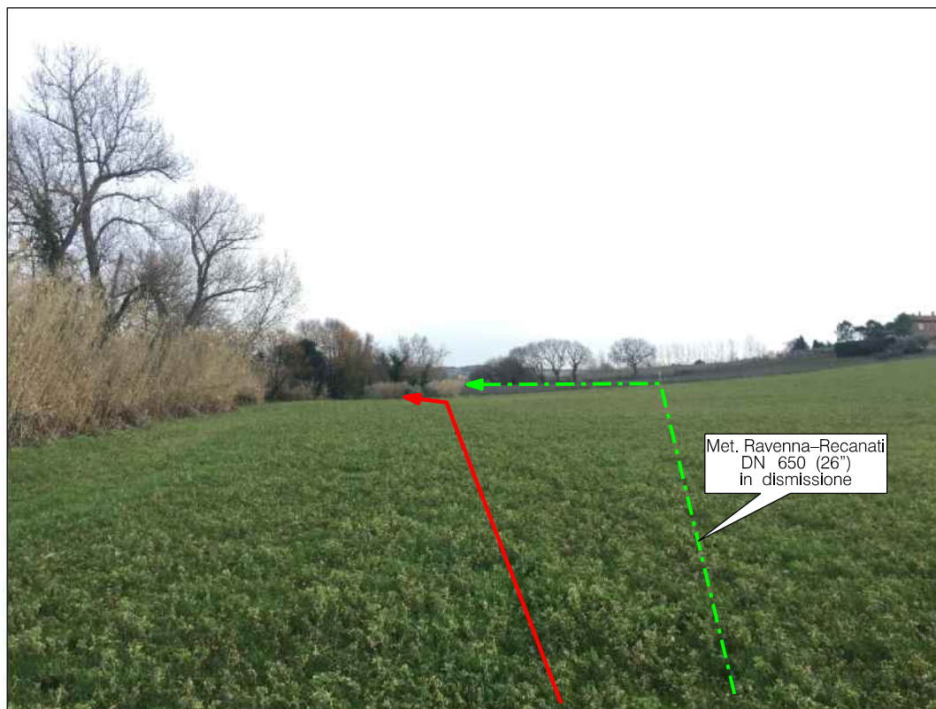
Panoramica del tracciato in prossimità del Fosso Selva Grossa, in Comune di Tavullia
