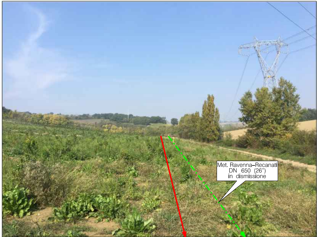
Percorrenza della condotta in seminativi in prossimita' del Torrente Arzilla, in Comune di Monteciccardo
