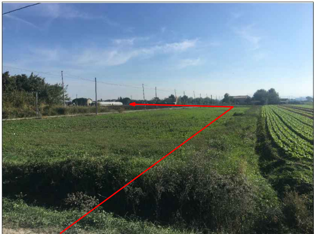
Panoramica del tracciato in prossimità del Fiume Uso, in Comune di San Mauro Pascoli
