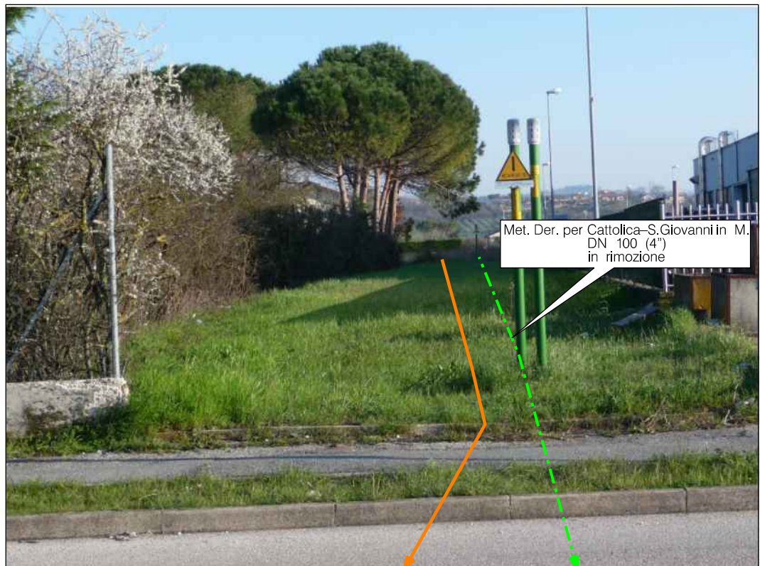
Panoramica del tracciato in zona artigianale nord in Comune di Cattolica
