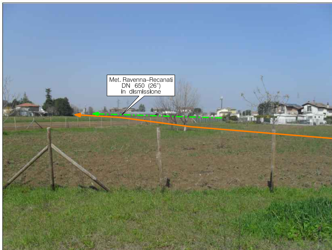
Panoramica del tracciato in senso gas, a sud della Frazione Santa Giustina in Comune di Rimini
