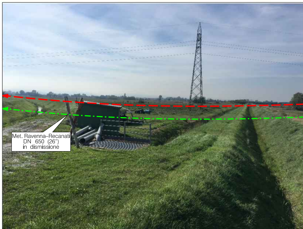
Attraversamento in T.O.C. dello Scolo Rigoncello, in Comune di Cesenatico
