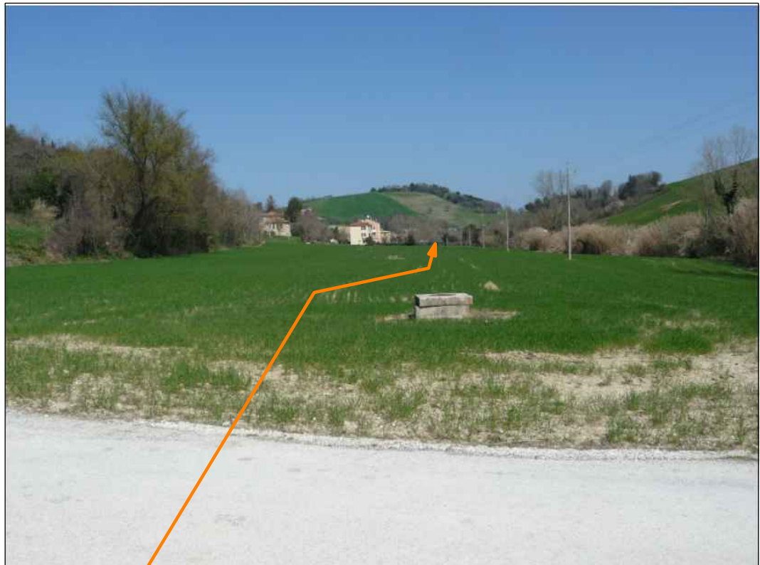
Panoramica del tracciato in senso gas in Comune di Ancona
