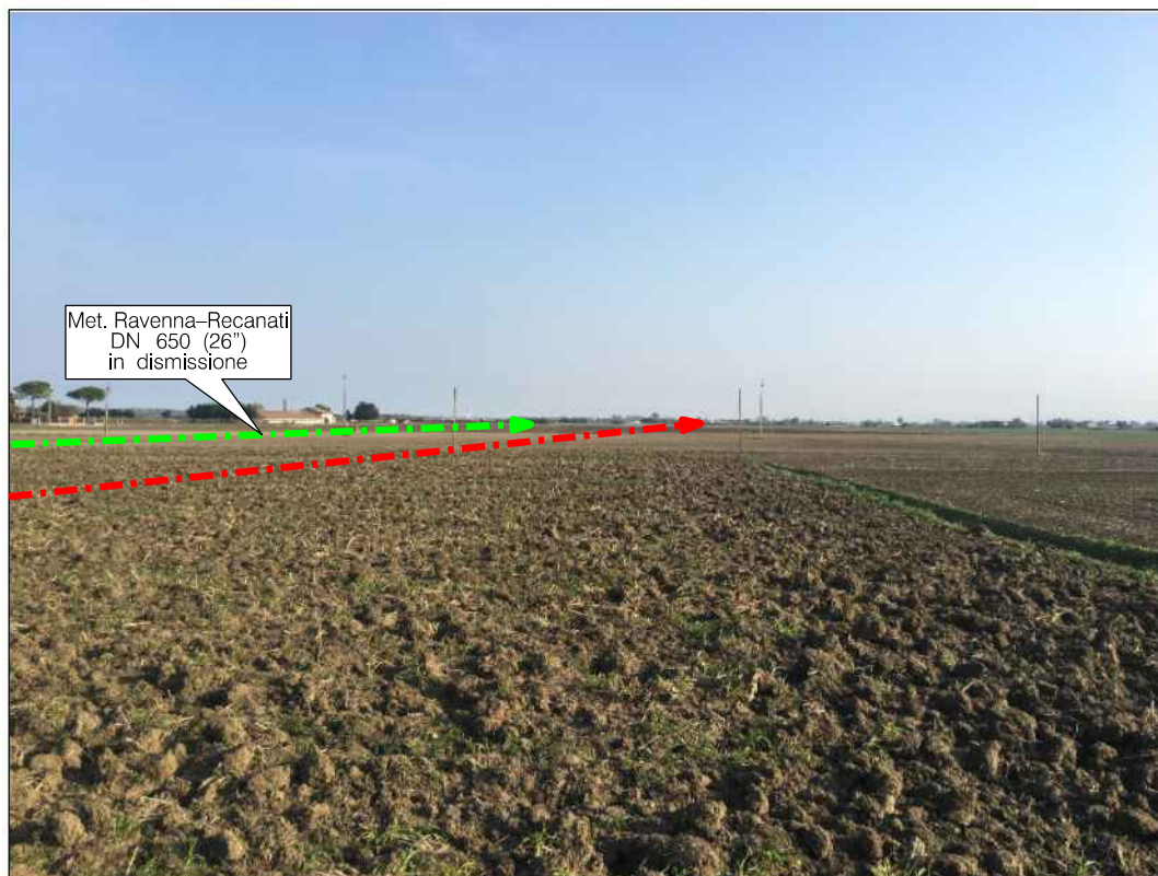
Percorrenza del tracciato in prossimita' della S.S. n.71bis, in Comune di Cervia
