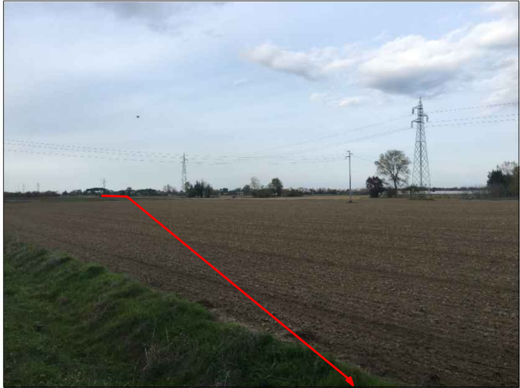
Percorrenza della condotta in seminitavi in prossimita' dello Scolo Rigossa, in Comune di Cesenatico
