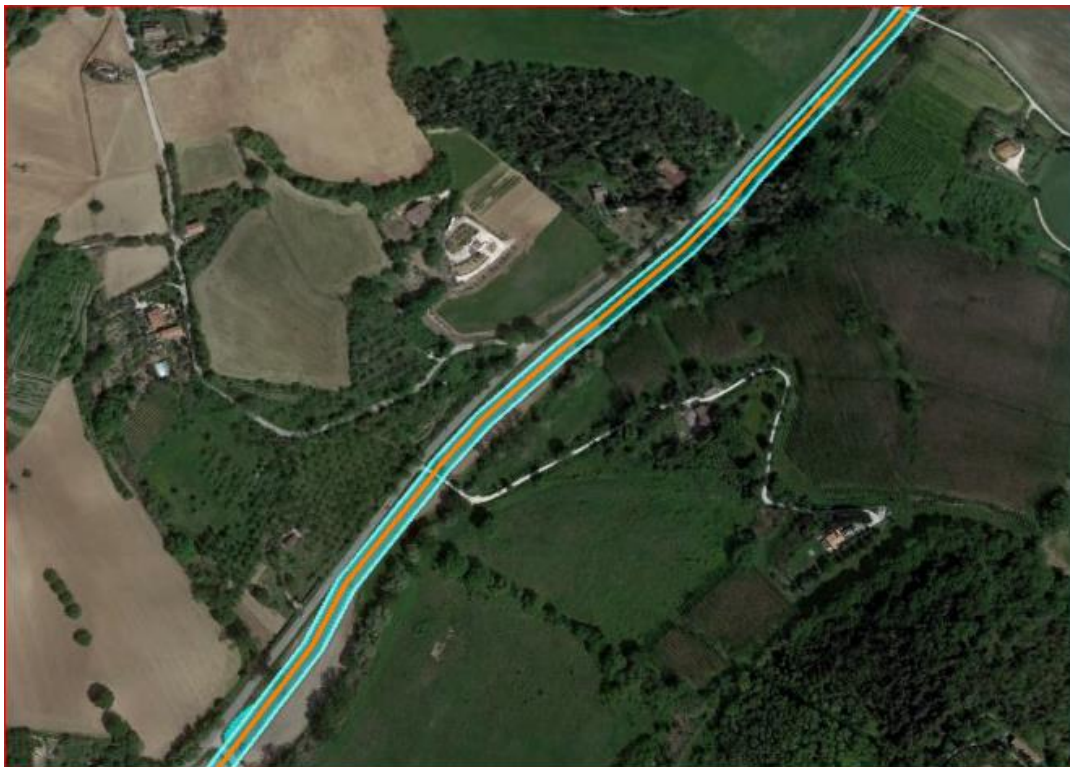
Foto n. 1.2.2/C: Esempio di sistemi particellari complessi lungo il tracciato del rifacimento "Derivazione per Ancona"
