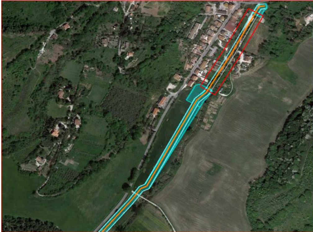
Foto n. 1.2.2/D: Esempio di aree prevalentemente occupate da colture agrarie con presenza di spazi naturali importanti lungo il rifacimento “Derivazione per Ancona”
