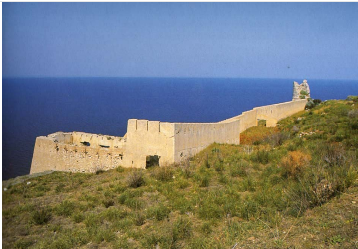
Torre Cavallo: cinta muraria borbonica
