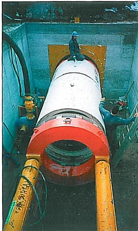
**Fig. 9.2/D: Postazione di spinta in c.a. e stazione di spinta**
