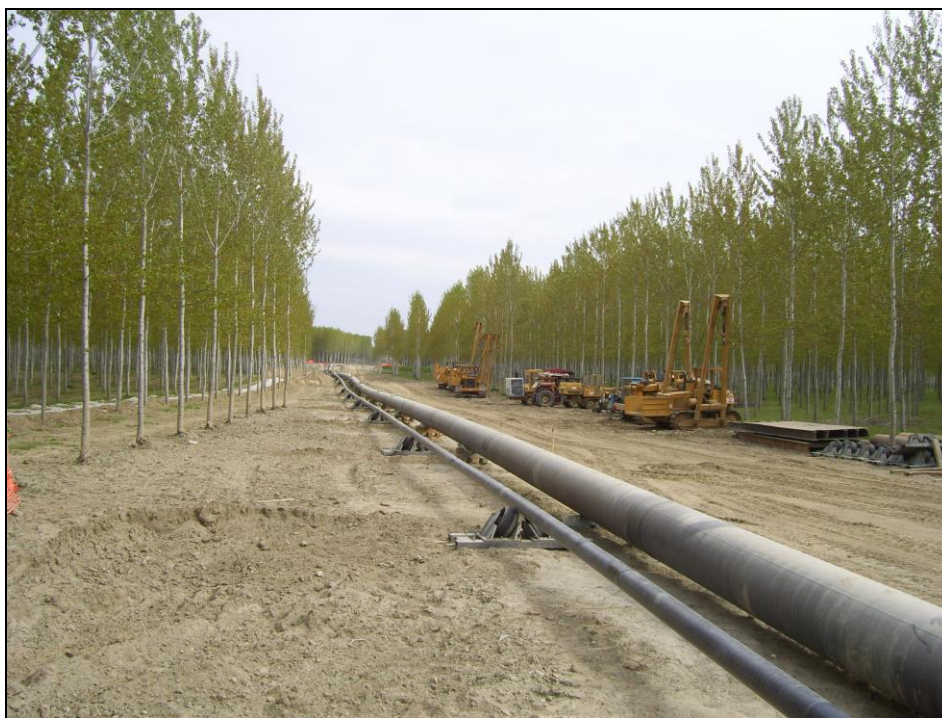
Attrav. F. Po con met. 30" – Colonna del pipeline preassemblata sulla pista di varo
