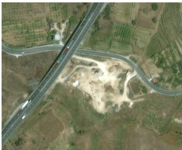
Figura 6.11 Foto aerea con ubicazione cantiere CC1
