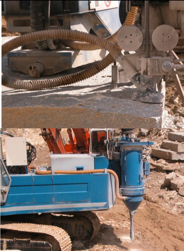
cappa aspirante calata a bocca foro durante la perforazione
