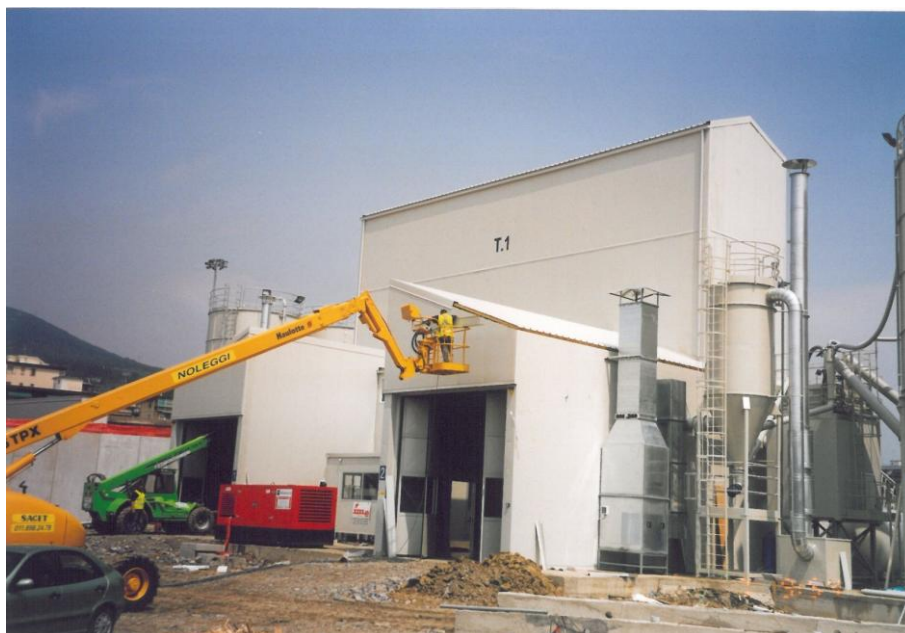
Figura 1.47 Vista complessiva impianto insonorizzato
