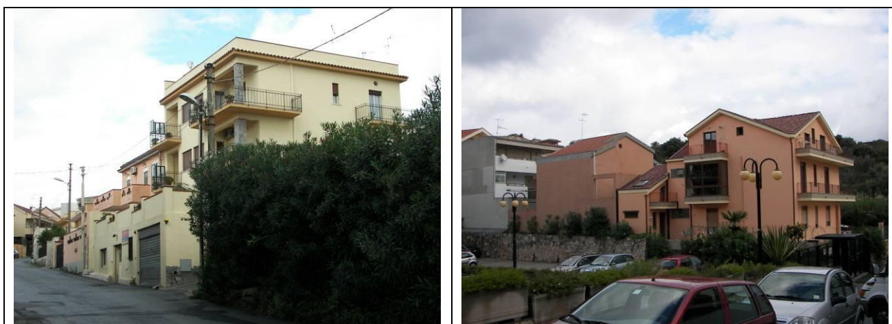
Figura 1.22 Ricettori cantiere SS1 Papardo
