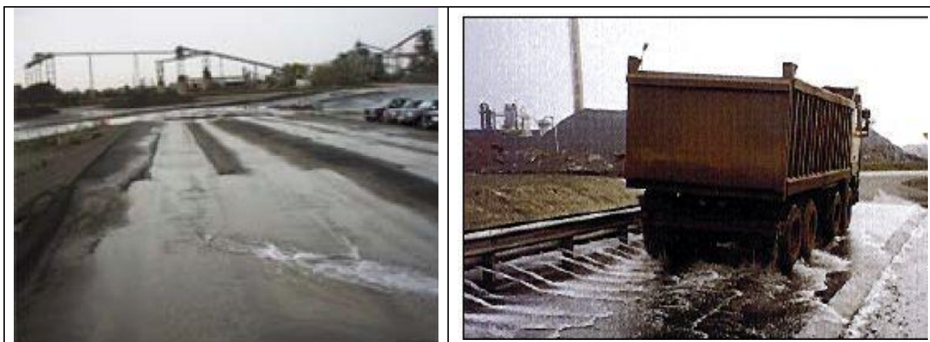
Figura 3.35 – Canali di lavaggio in controcorrente
