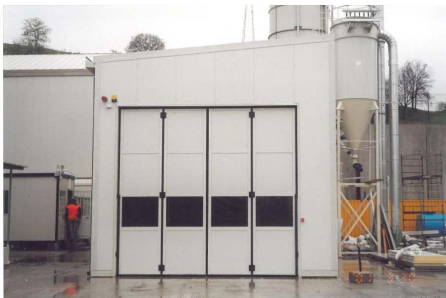
Figura 1.46 Insonorizzazione area di carico betoniere
