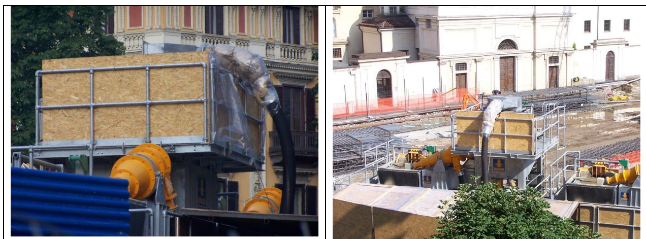
Figura 1.48 Insonorizzazione impianto dissabbiatore
