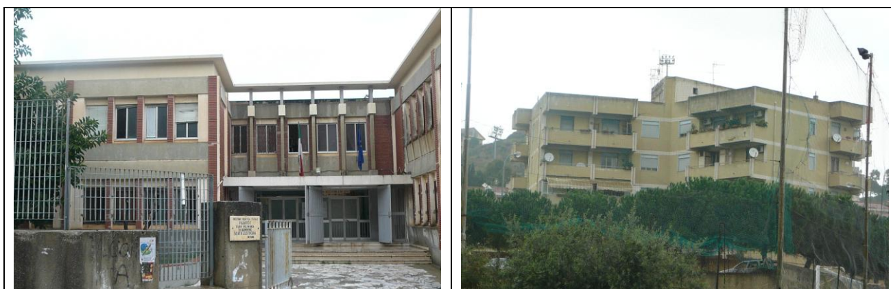
Figura 1.25 Ricettori cantiere SS2 Annunziata
