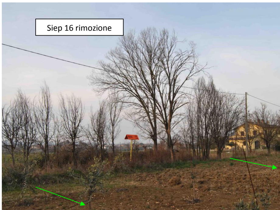
Foto 3.48/B - Tratto di filare da abbattere all'interno (in verde) della fascia di lavoro
