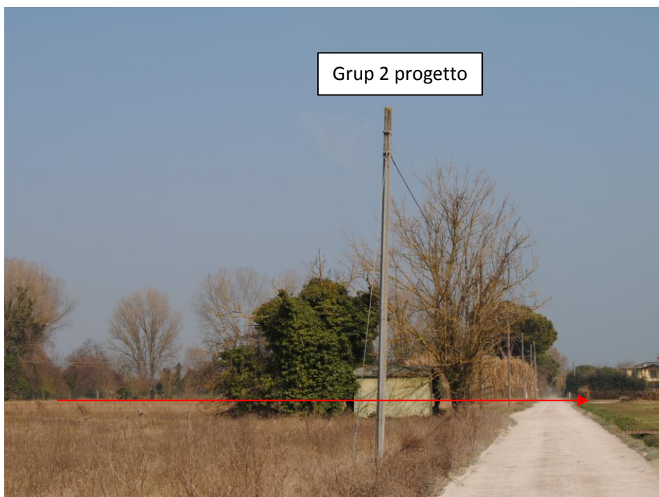
Foto 1.3/B - Porzione di gruppo da abbattere di fianco alla linea in progetto (in rosso)
