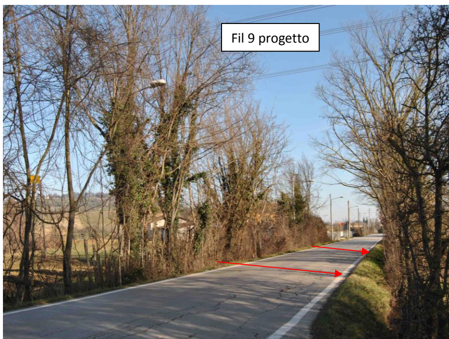
Foto 1.24/B - Tratto di filare da abbattere all'interno (in rosso) della fascia di lavoro
