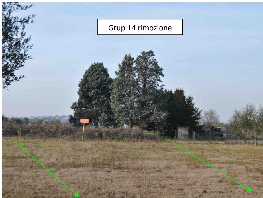
Foto 3.44/B - Porzione di gruppo da abbattere all'interno (in verde) della fascia di lavoro
