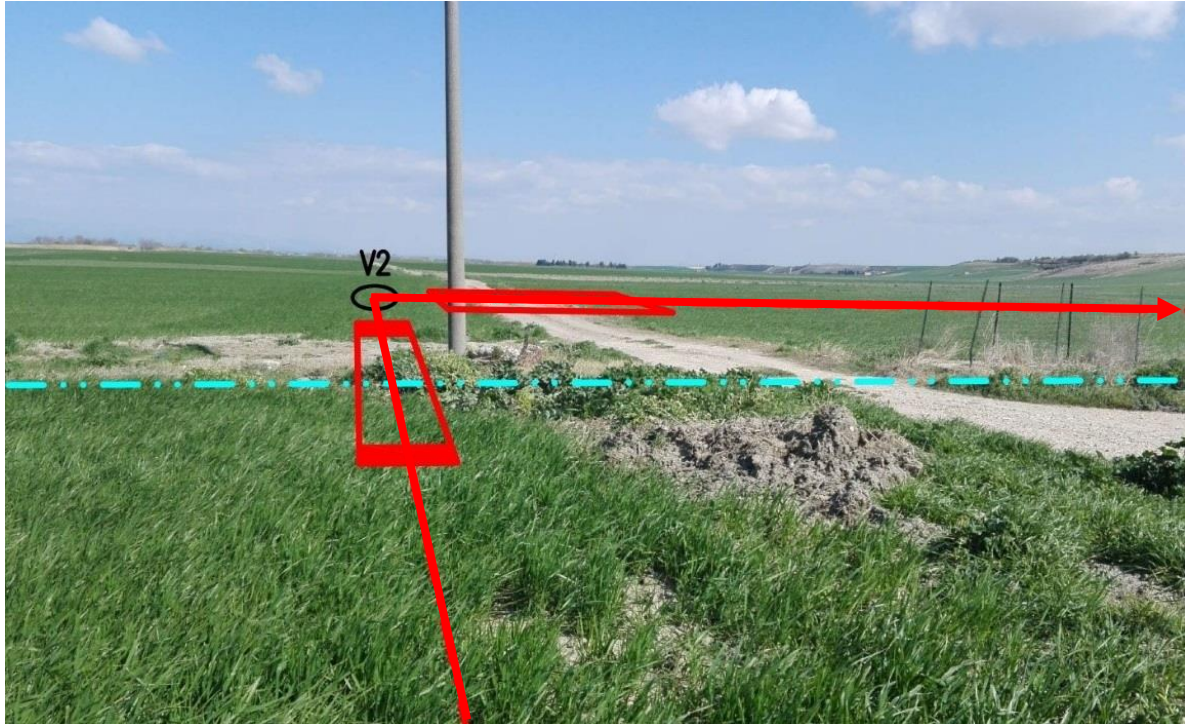
Fig. 3 – Foto ricostruzione metanodotto in progetto - “MET. ALL.TO BIO ECOAGRIM S.r.l di Lucera DN 100 (4”) – 75 bar - attraversamento strada Vicinale Ripatetta e strada brecciata
