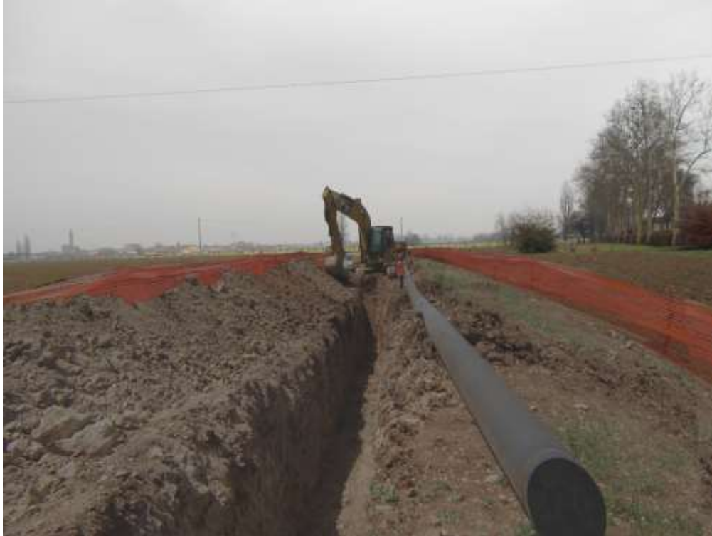
Fig. 3/B: Panoramica percorrenza in area agricola. Cantiere in corso
