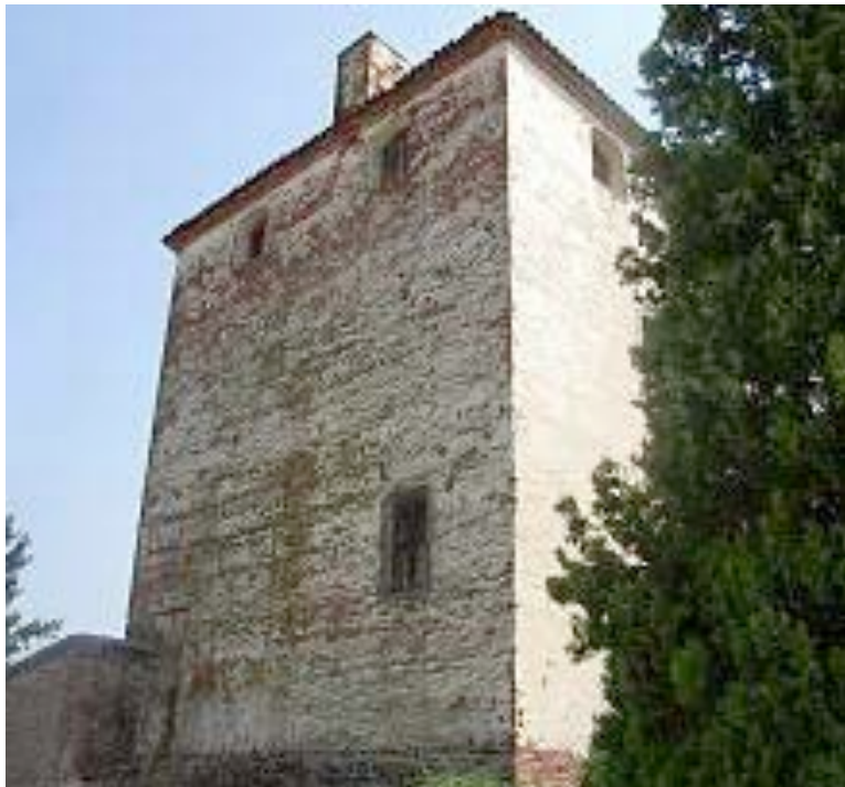
Fig. 18. Vista del centro Torriente duecentesca di Rampazzo
