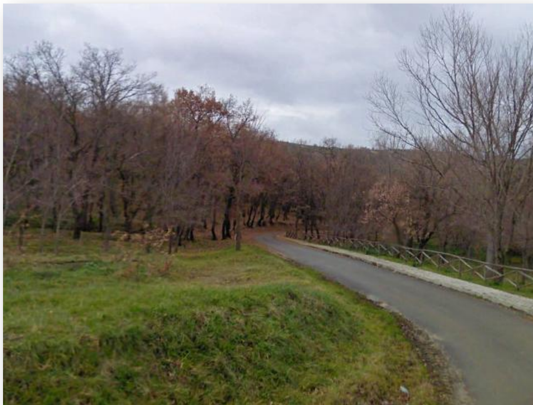
Figura 122: Strada interna all'area boscata interessata dal percorso di cavidotto interrato
