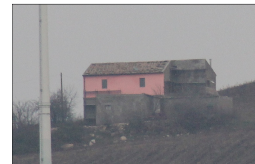
Fabbricato n. 1 - Censito al N.C.E.U. come Magazzino
