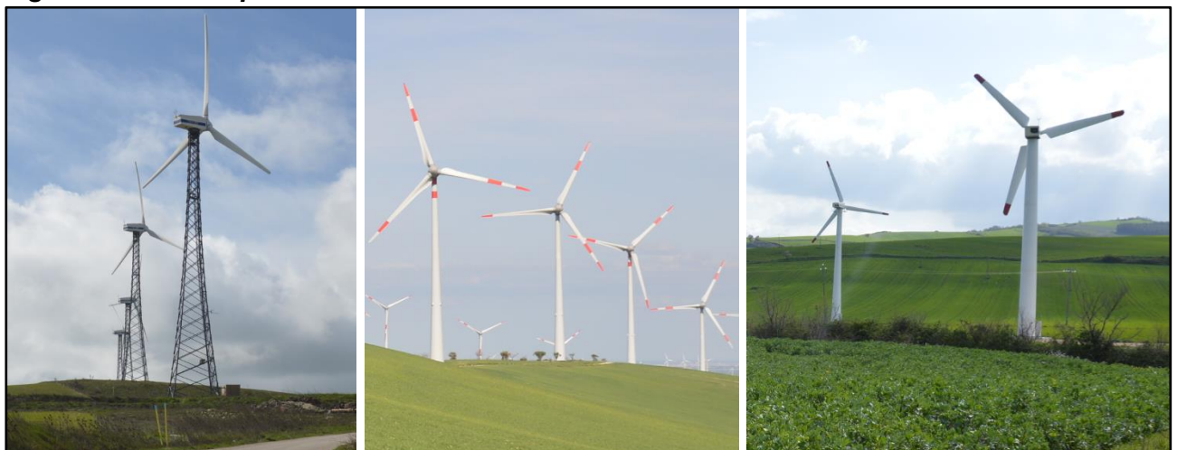
Figura 4.2.7.3a Impianti eolici nell'Area di Studio
