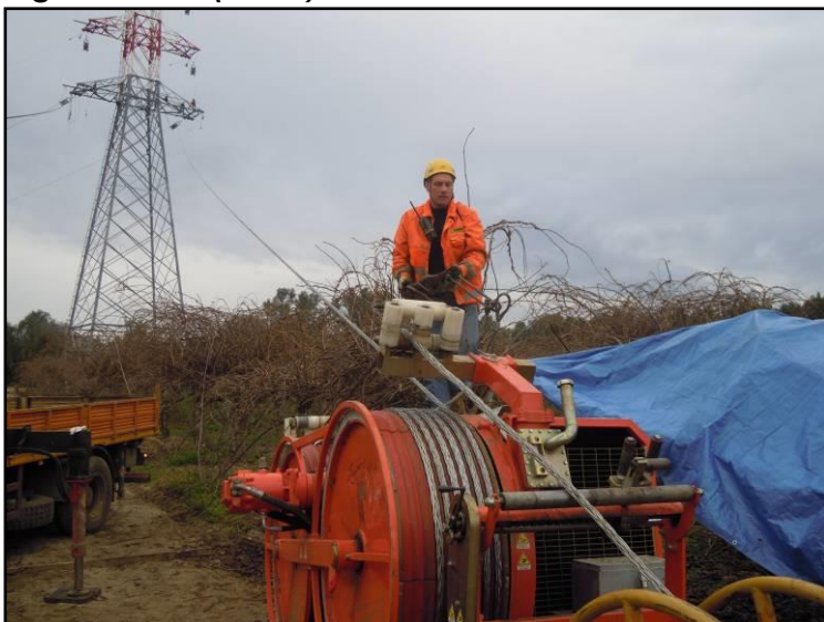
Figura 4.3.4b (2 di 3) Fasi di tesatura della linea elettrica
