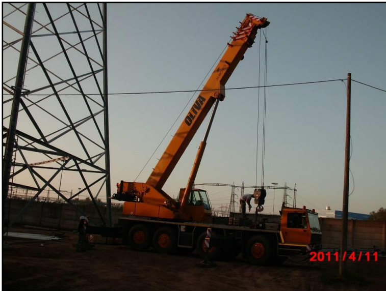
Figura 4.3.3a (2 di 3) Fasi di montaggio sostegno a traliccio
