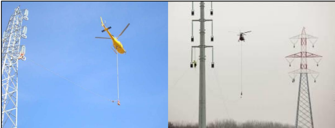
Figura 4.3.4a Utilizzo dell'elicottero per la stesura della fune pilota
