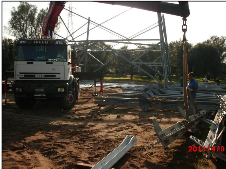
Figura 4.3.3a (3 di 3) Fasi di montaggio sostegno a traliccio
