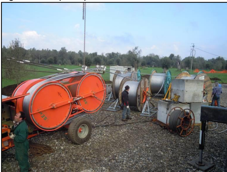
Figura 4.3.4b (1 di 3) Fasi di tesatura della linea elettrica
