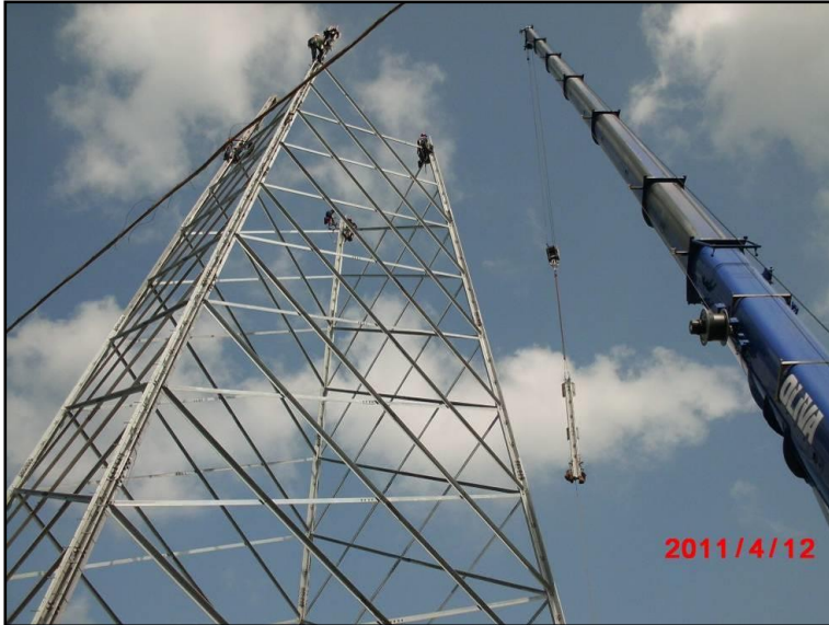
Figura 4.3.3a (1 di 3) Fasi di montaggio sostegno a traliccio
