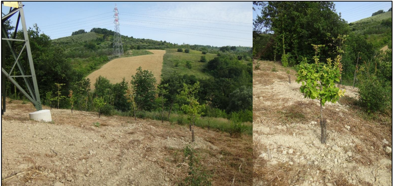
Figura 4.3.6a Esempio di ripristino di un micro-cantiere localizzato su un versante
