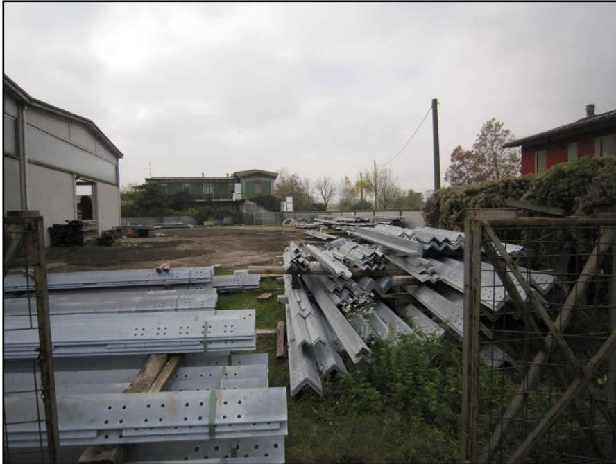
Figura 4.3.1.1e Area centrale – Deposito materiale
