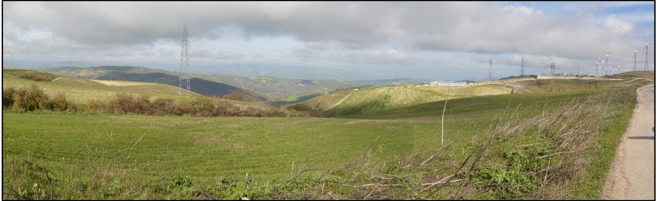
Figura 3.4l Vista sulla vallata ed ovest dei Monti Dauni, a destra la Stazione Elettrica di Alberona
