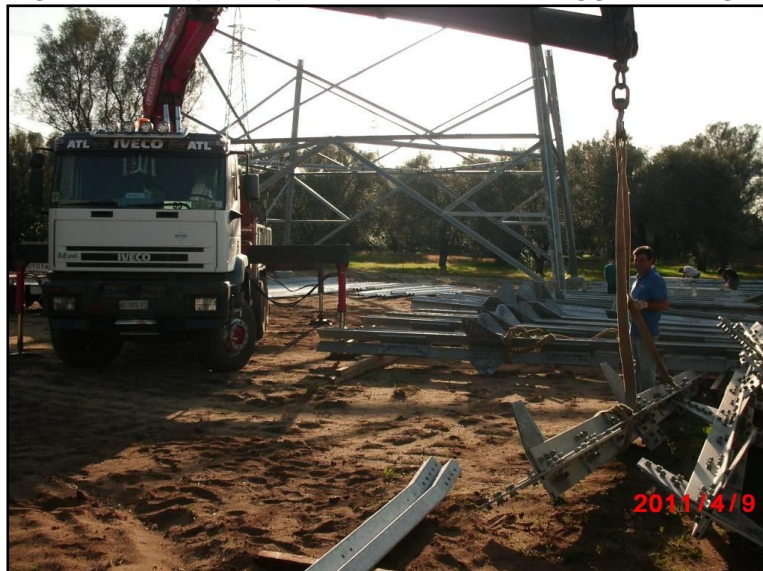
Figura 2.3.3a (3 di 3) Fasi di montaggio sostegno a traliccio
