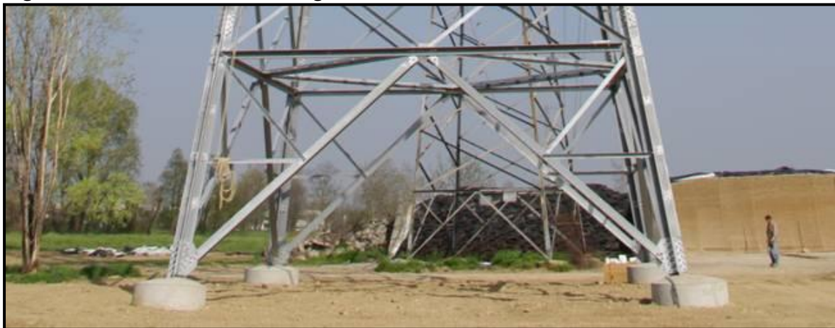
Figura 4.1.1a Base del Sostegno Reticolare a Traliccio
