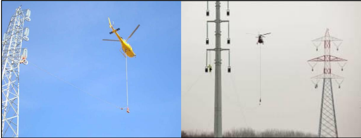
Figura 2.3.4a Utilizzo dell'elicottero per la stesura della fune pilota
