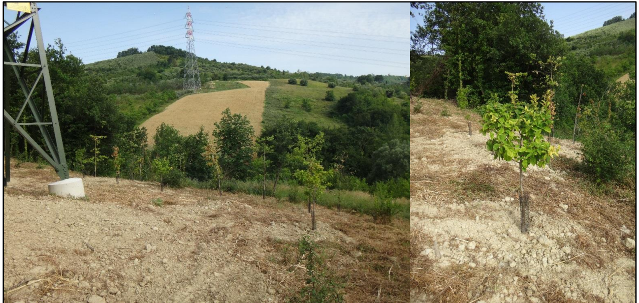
Figura 2.3.6a Esempio di ripristino di un micro-cantiere localizzato su un versante
