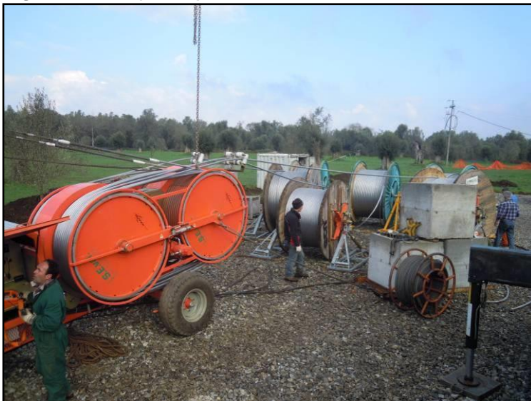
Figura 2.3.4b (1 di 3) Fasi di tesatura della linea elettrica
