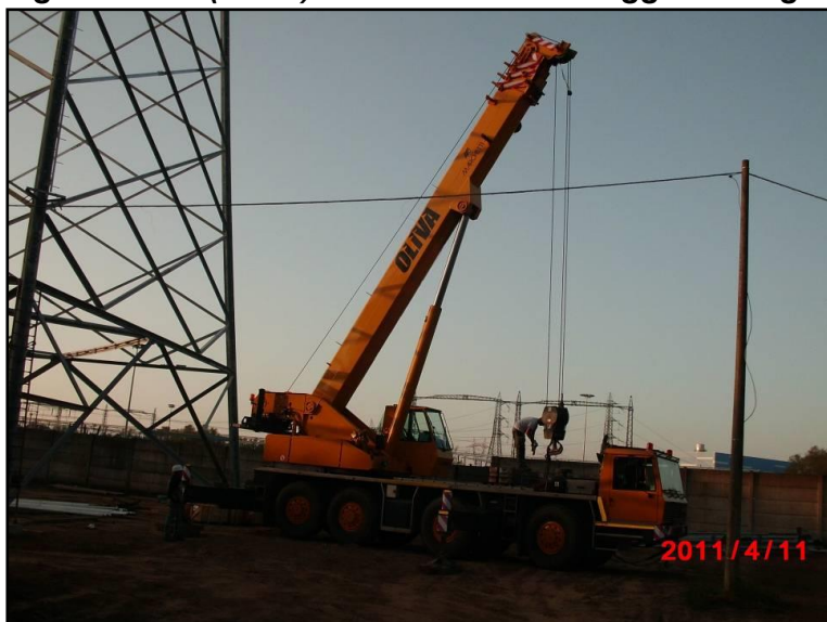
Figura 2.3.3a (2 di 3) Fasi di montaggio sostegno a traliccio
