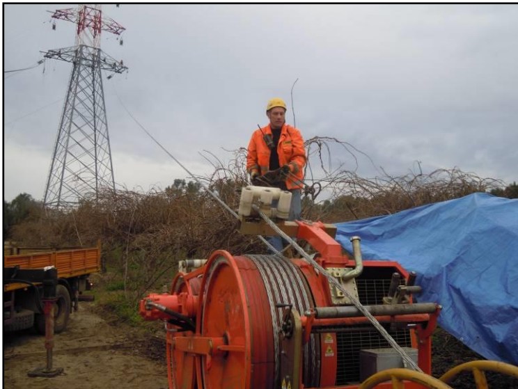
Figura 2.3.4b (2 di 3) Fasi di tesatura della linea elettrica
