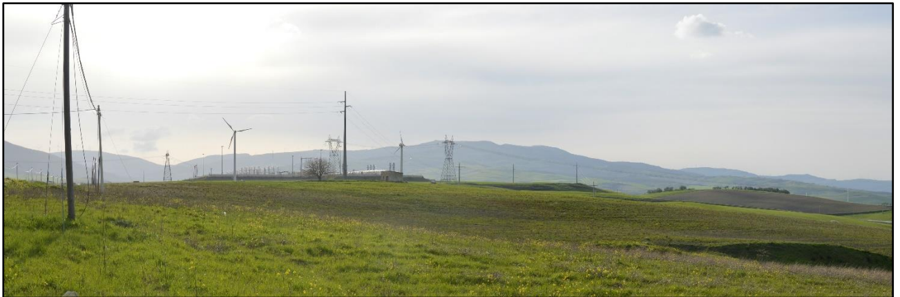
Figura 3.4a Stazione Elettrica SE Troia, linee elettriche e pale eoliche
