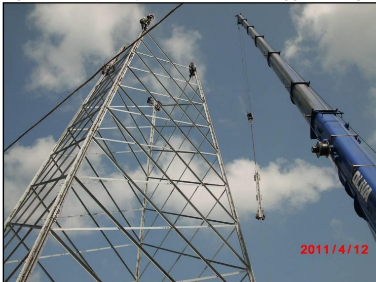
Figura 2.3.3a (1 di 3) Fasi di montaggio sostegno a traliccio
