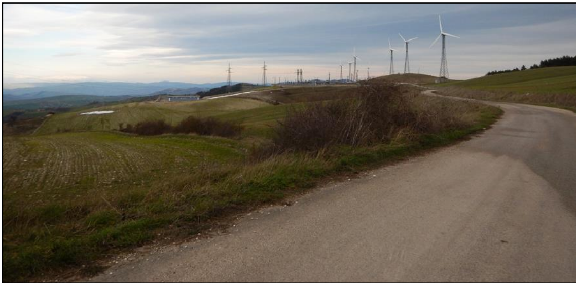
Figura 5.12j Area Stazione Elettrica Alberona da SE
