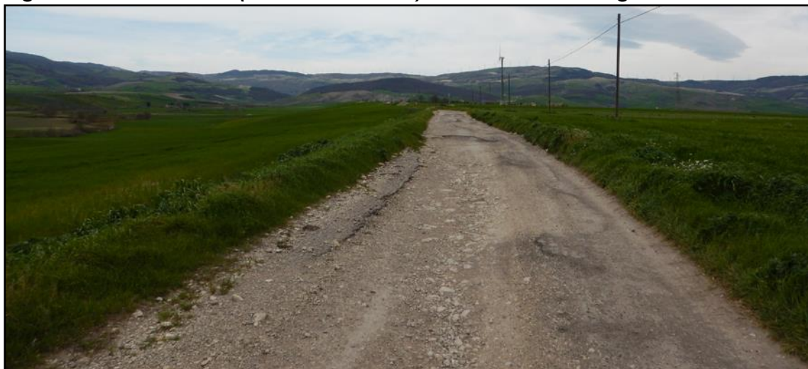
Figura 5.9b SP 133 (vecchio tracciato) da Est e area sostegno 31
