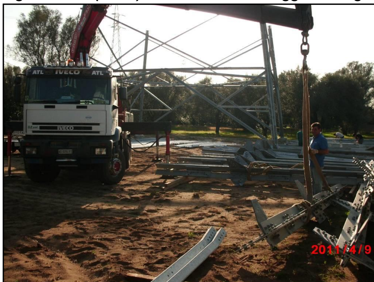
Figura 2.3.3a (3 di 3) Fasi di montaggio sostegno a traliccio
