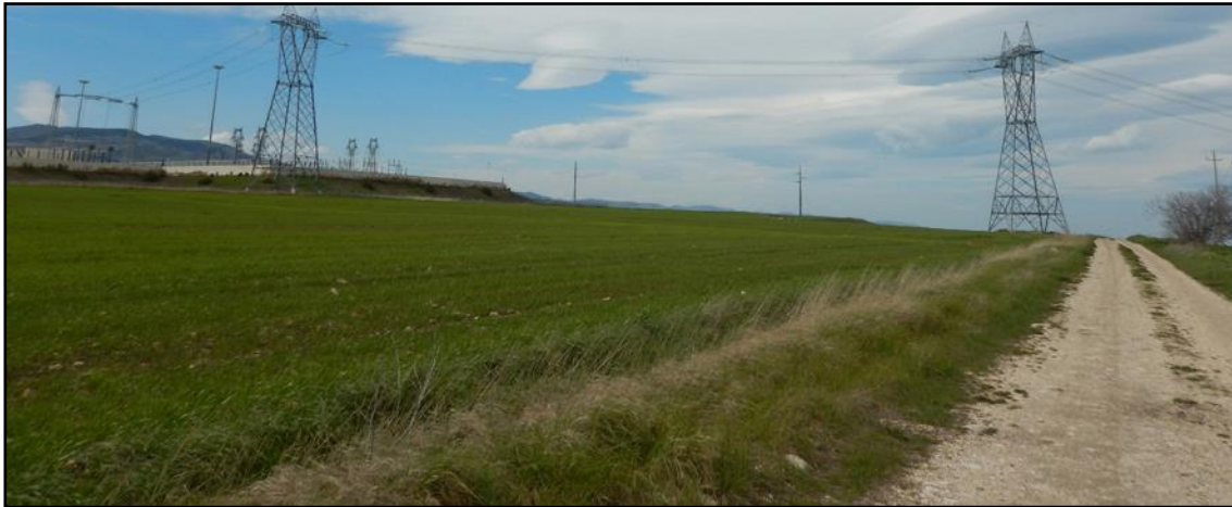
Figura 5.1b Area della Stazione Elettrica di Troia (a sinistra), da Sud
