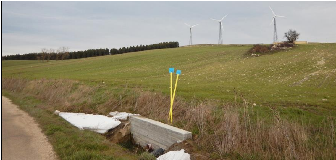
Figura 5.12i Area sostegno 49 da Est
