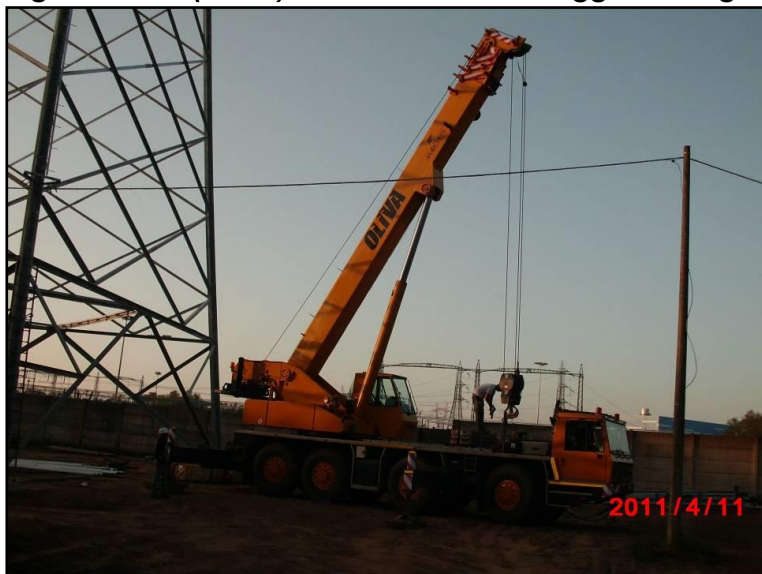
Figura 2.3.3a (2 di 3) Fasi di montaggio sostegno a traliccio
