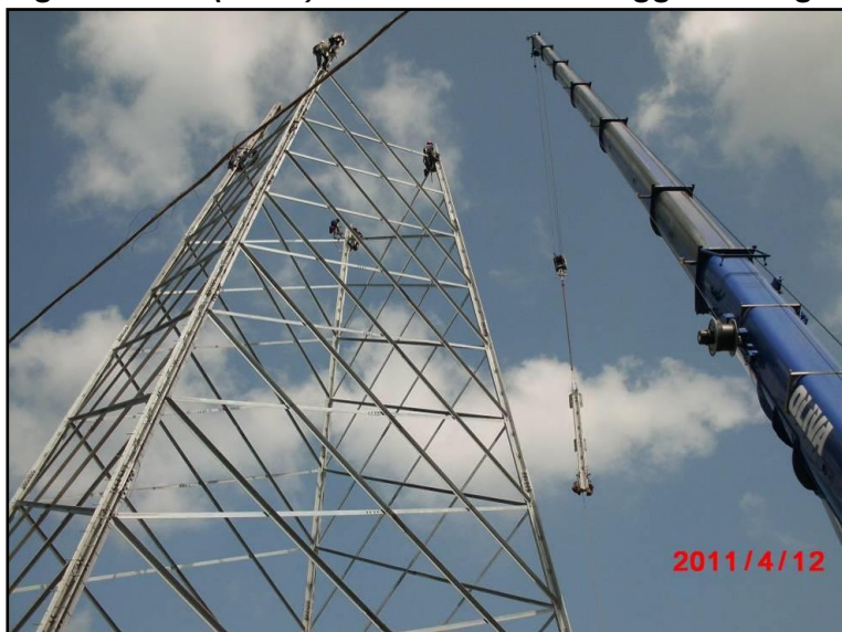
Figura 2.3.3a (1 di 3) Fasi di montaggio sostegno a traliccio
