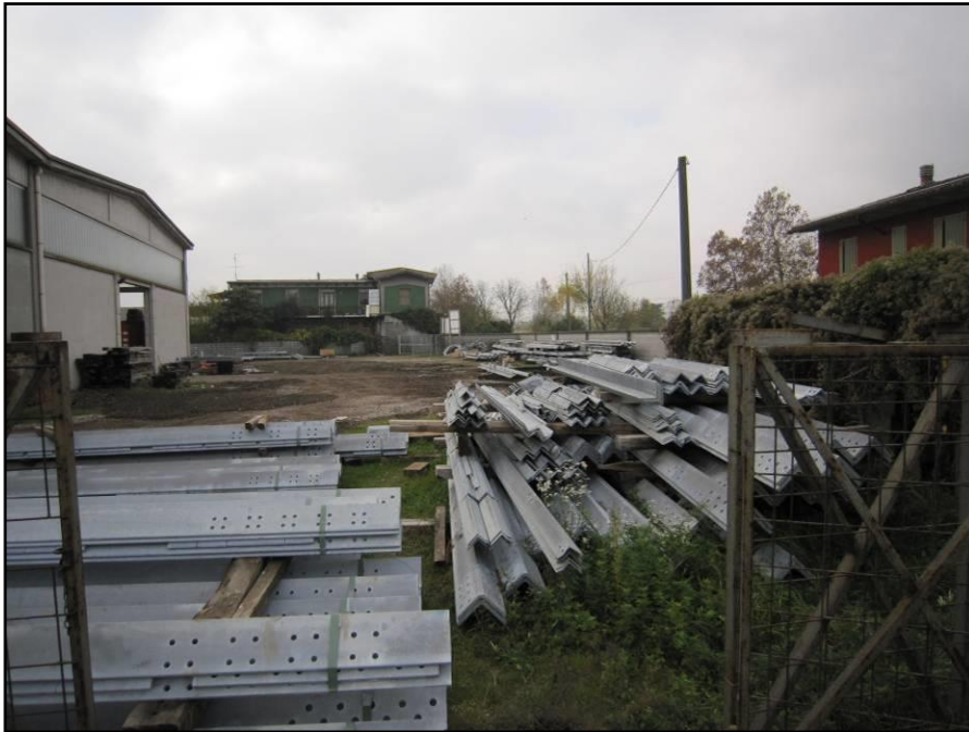
Figura 3.5.1.1e Area centrale – Deposito materiale
