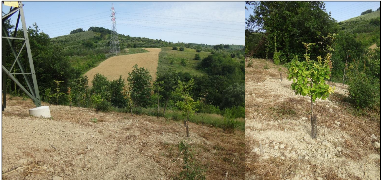
Figura 3.5.6a Esempio di ripristino di un micro-cantiere localizzato su un versante
