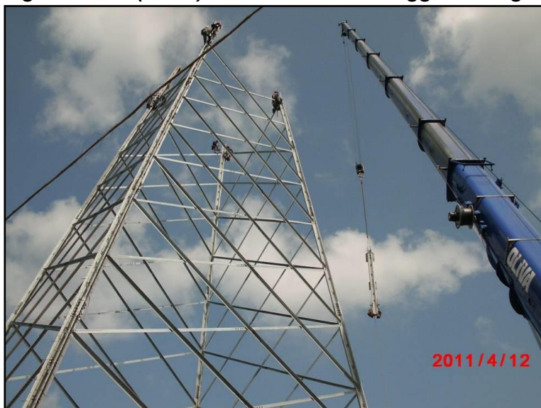
Figura 3.5.3a (1 di 3) Fasi di montaggio sostegno a traliccio
