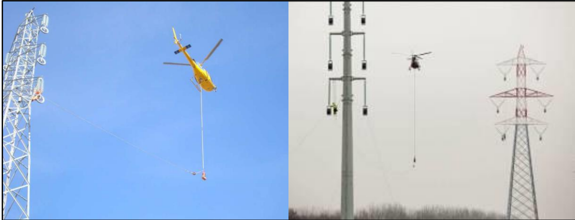
Figura 3.5.4a Utilizzo dell'elicottero per la stesura della fune pilota
