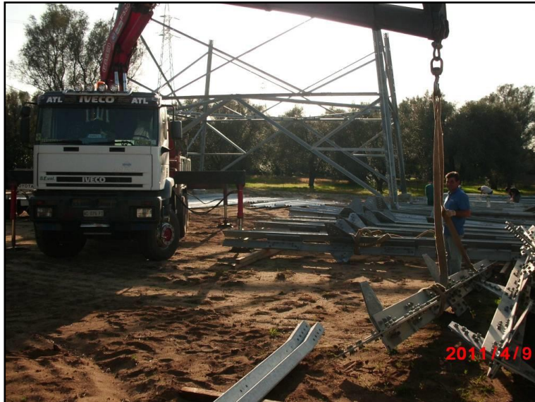
Figura 3.5.3a (3 di 3) Fasi di montaggio sostegno a traliccio
