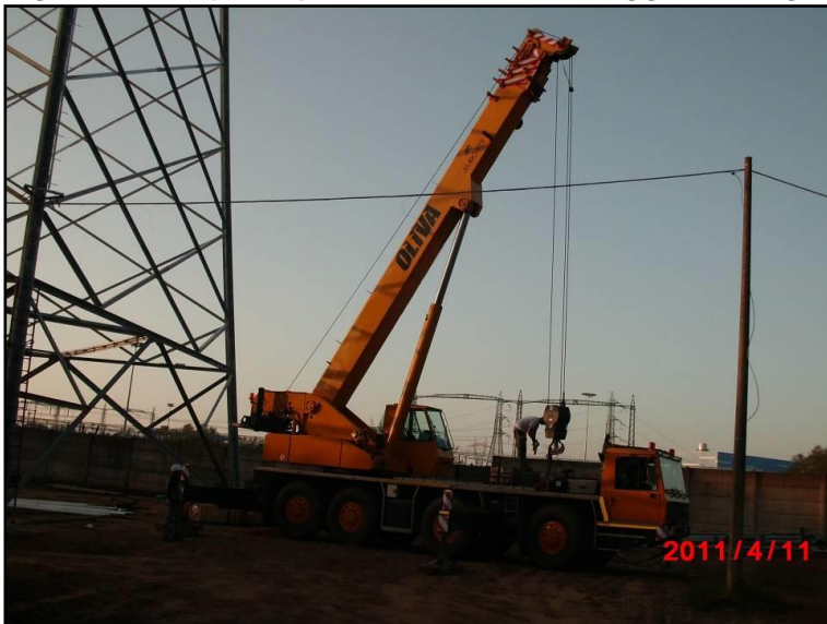
Figura 3.3.3a (2 di 3) Fasi di montaggio sostegno a traliccio
