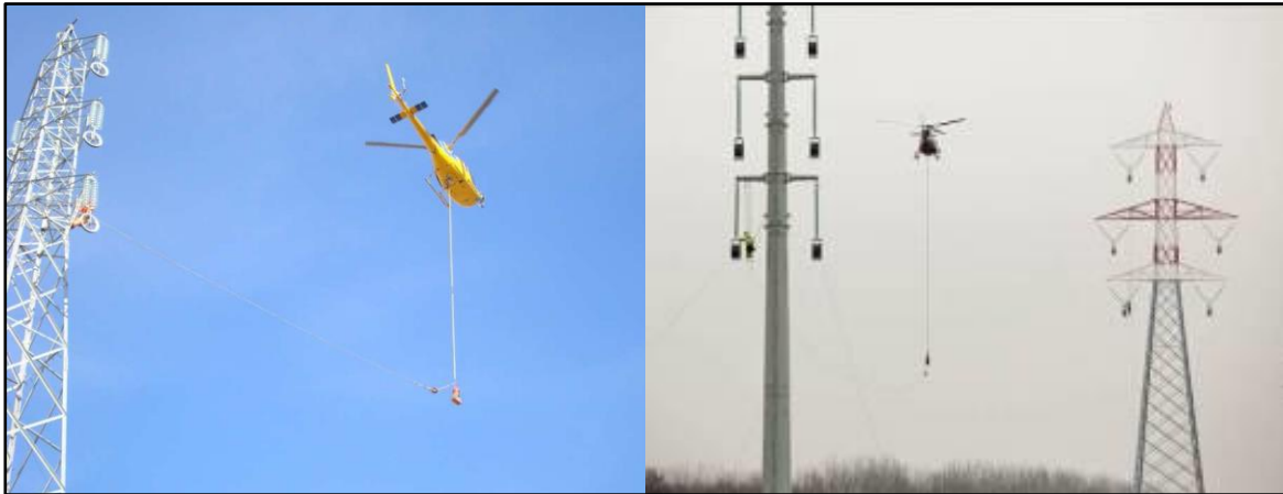
Figura 3.3.4a Utilizzo dell'elicottero per la stesura della fune pilota
