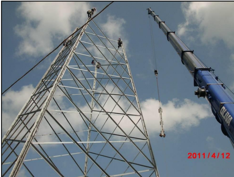
Figura 3.3.3a (1 di 3) Fasi di montaggio sostegno a traliccio
