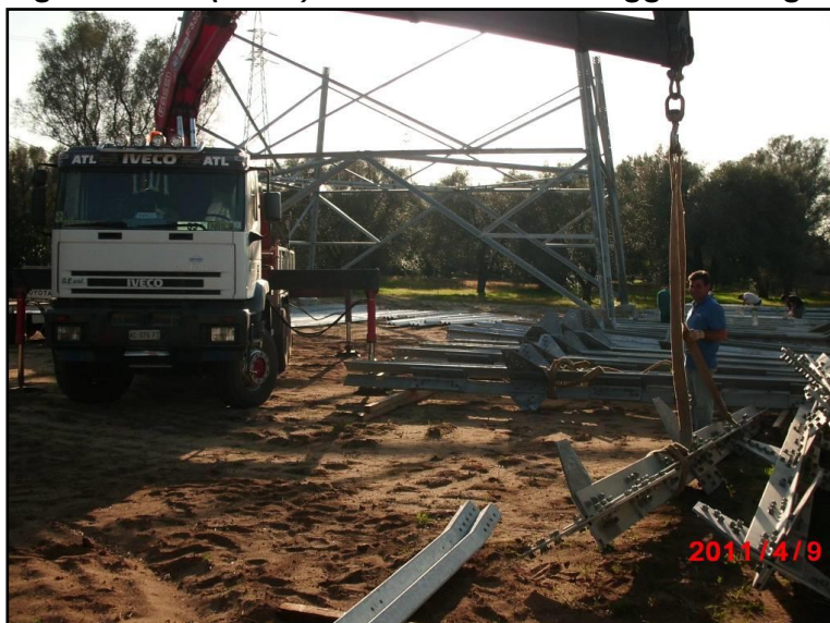
Figura 3.3.3a (3 di 3) Fasi di montaggio sostegno a traliccio
