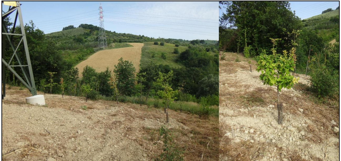
Figura 3.3.6a Esempio di ripristino di un micro-cantiere localizzato su un versante
