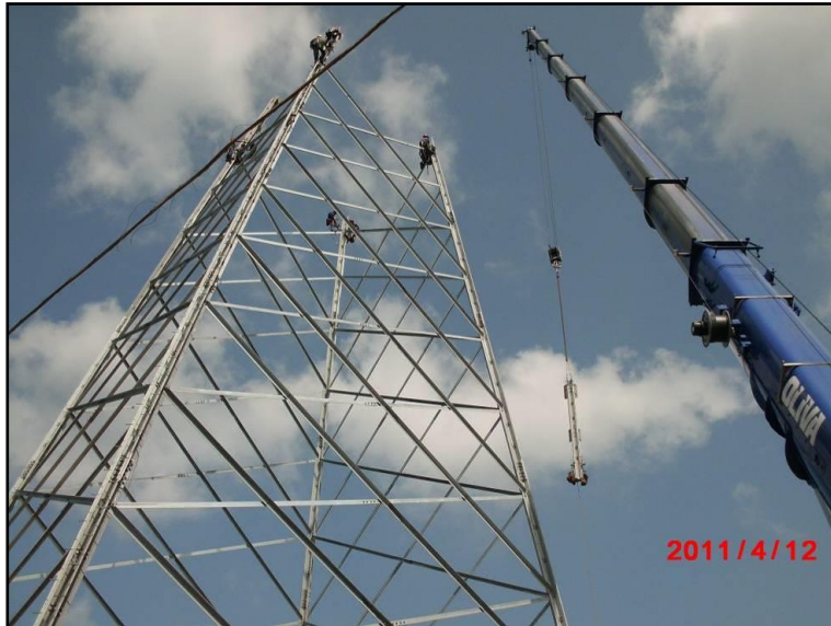
Figura 3.3.3a (1 di 3) Fasi di montaggio sostegno a traliccio
