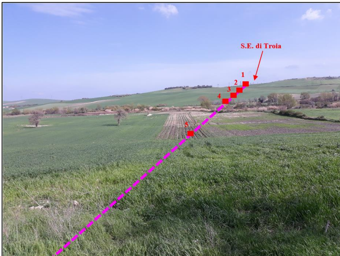
Figura 12a Panoramica sul tracciato dal sostegno 6 verso i sostegni 5, 4, 3, 2, 1 e Stazione Elettrica di Troia
