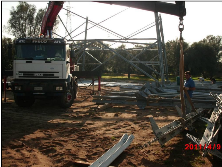
Figura 3.3.3a (3 di 3) Fasi di montaggio sostegno a traliccio
