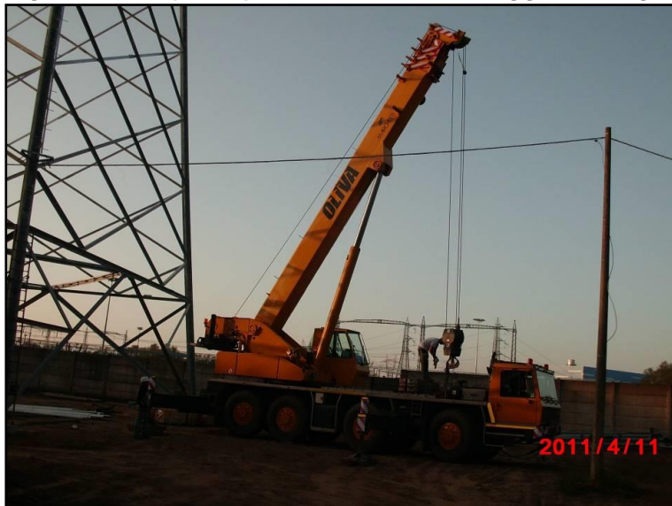
Figura 3.3.3a (2 di 3) Fasi di montaggio sostegno a traliccio
