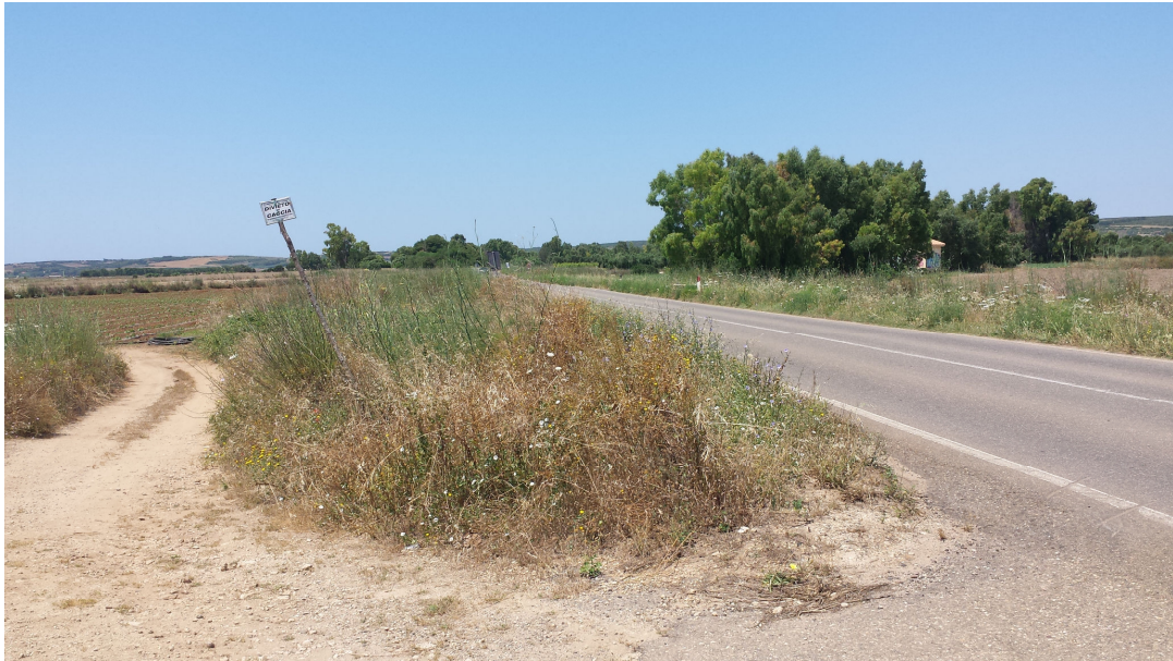
Foto d'inquadramento con dettaglio della strada Provinciale interessata dal progetto.
