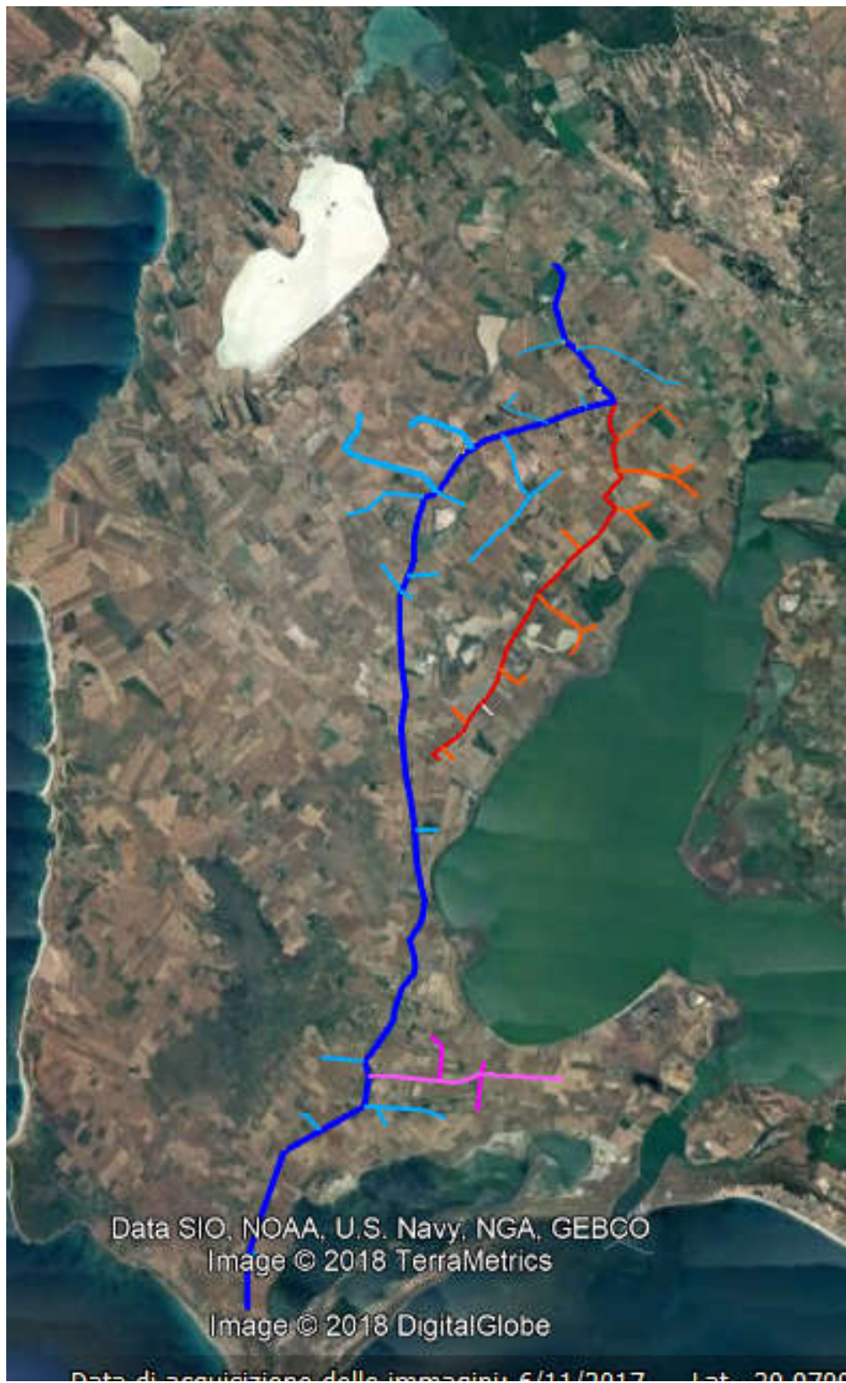
Figura 12. Tratto A nell'opera generale (da Google Earth).
