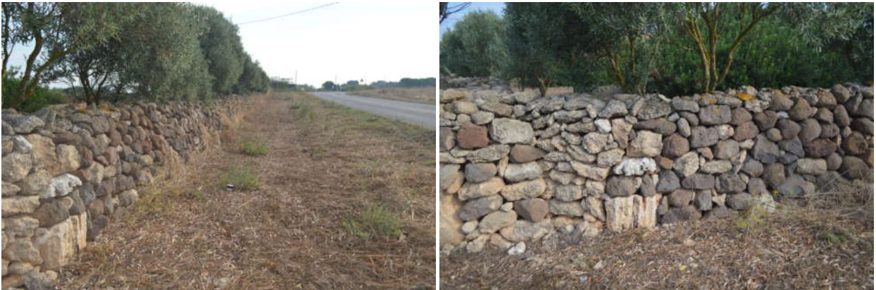
Figura 31. Strada provinciale 6, lato occidentale (da sud) e particolare struttura di recinzione che reimpiega un tratto di opus mixtum .
