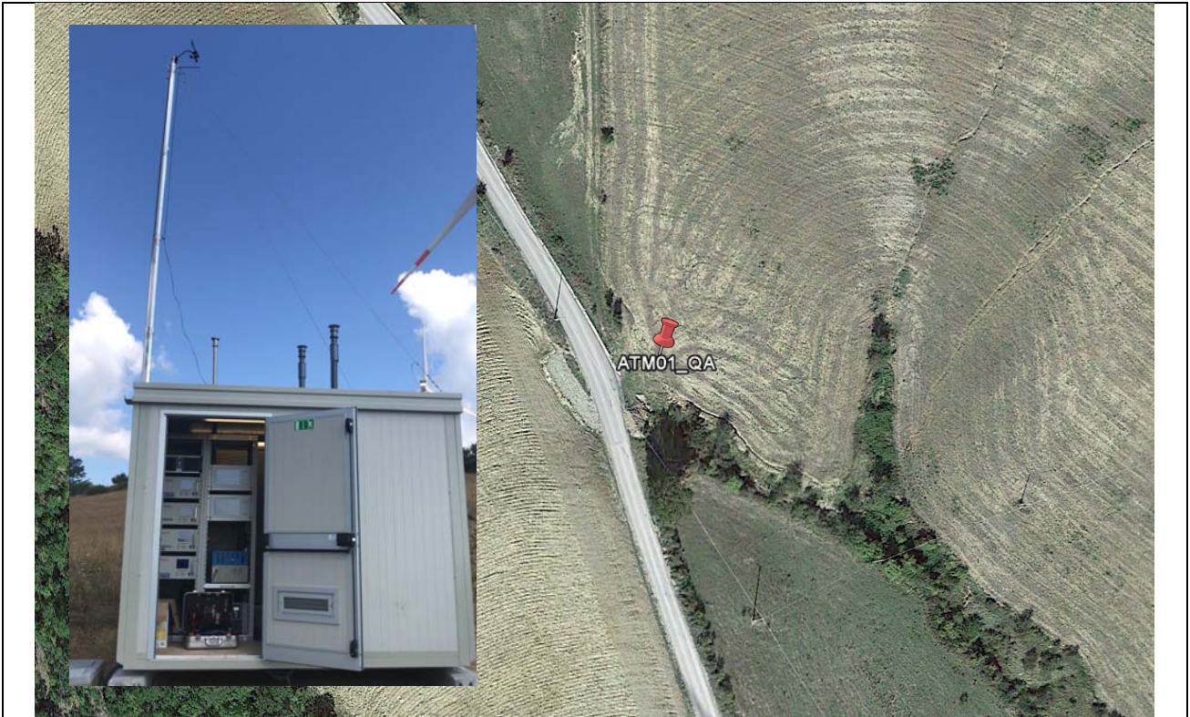
ATM01_QA – Stazione monitoraggio qualità dell'aria Gorgoglione (MT)
