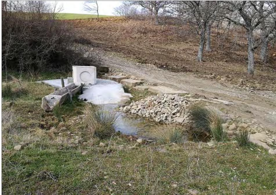
*Fig. 5.20 – Progressiva 1660 m: a monte della strada ristagno d'acqua in corrispondenza di una captazione*
