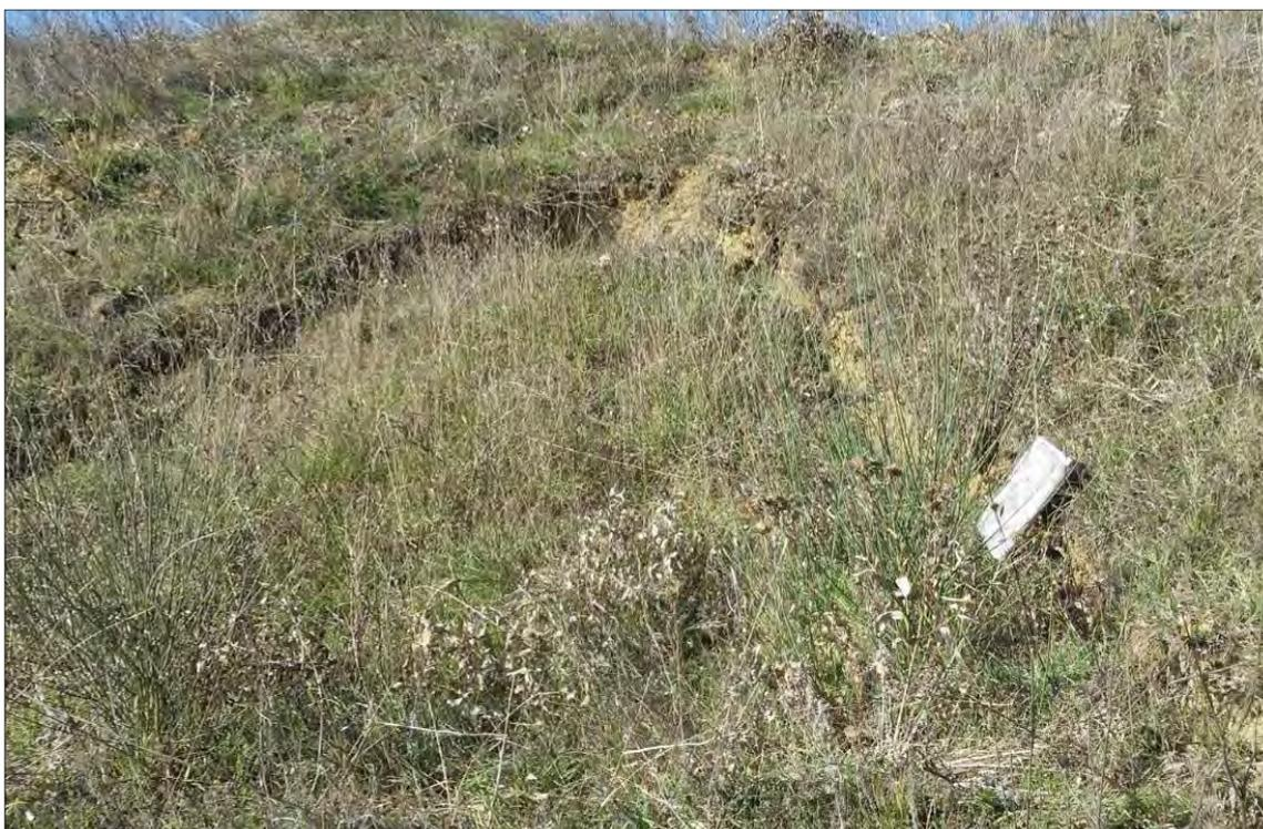
*Fig. 5.8 – Frana per scorrimento rotazionale nel tratto iniziale, con fenomeno incipiente (progr. 560-580 m)*
