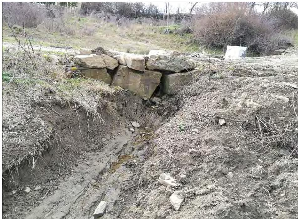
*Fig. 5.21 – Progressiva 1660 m: a valle della strada incisione artificiale e sostegno della sede stradale con massi di arenaria*
