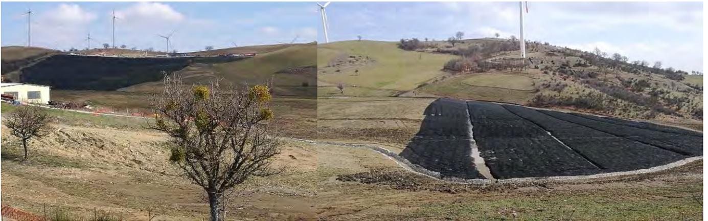
Fig. 5.14 – Progressive 690-820 m a valle della strada: fenomeno di ruscellamento diffuso
