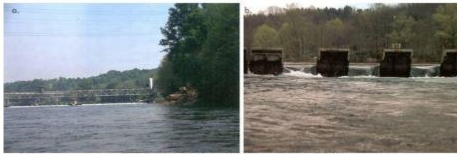
Figura 5-1: Diga della Miorina: a. veduta generale; b. particolare
