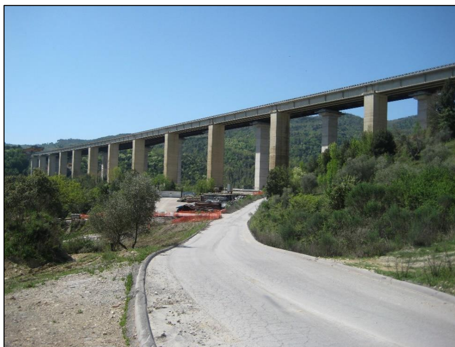
Figura 85 – Panoramica PA 07 – Vista viadotto Farma
