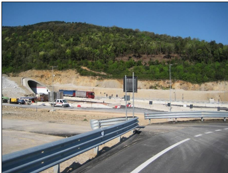
Figura 84 – Panoramica PA 06 – presso Galleria Casal di Pari
