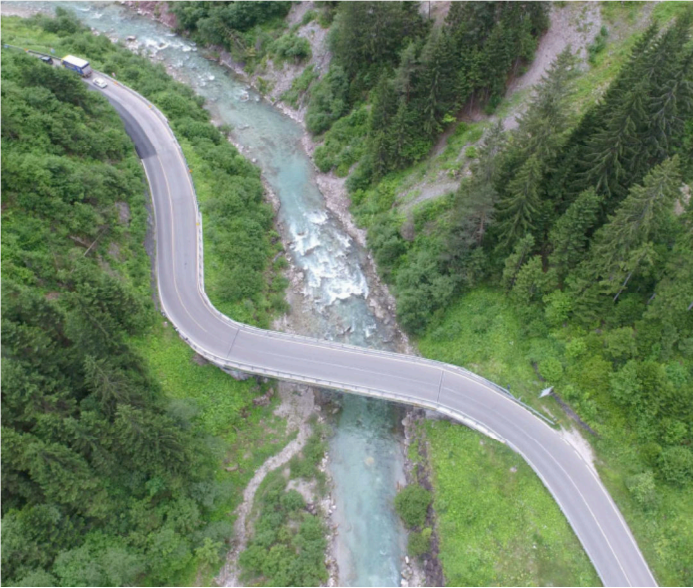
Figura 2: Stato attuale Ponte sul Piave al km 86+850 (Fonte: Lista di controllo)
