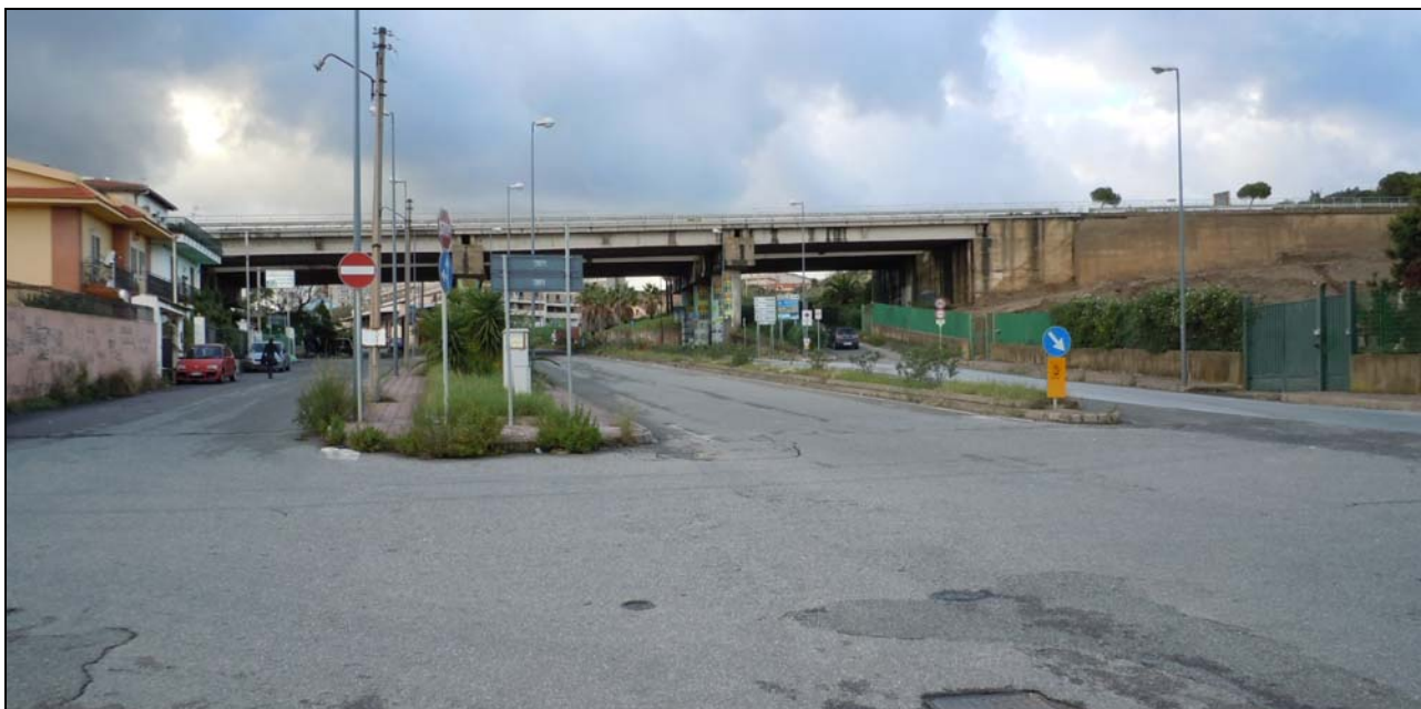
Fotografia 2-31: Salita Papardo. Sulla sinistra il tratto terminale dell'arco V-SE3.b. Sullo sfondo il viadotto della Strada Panoramica dello Stretto.
