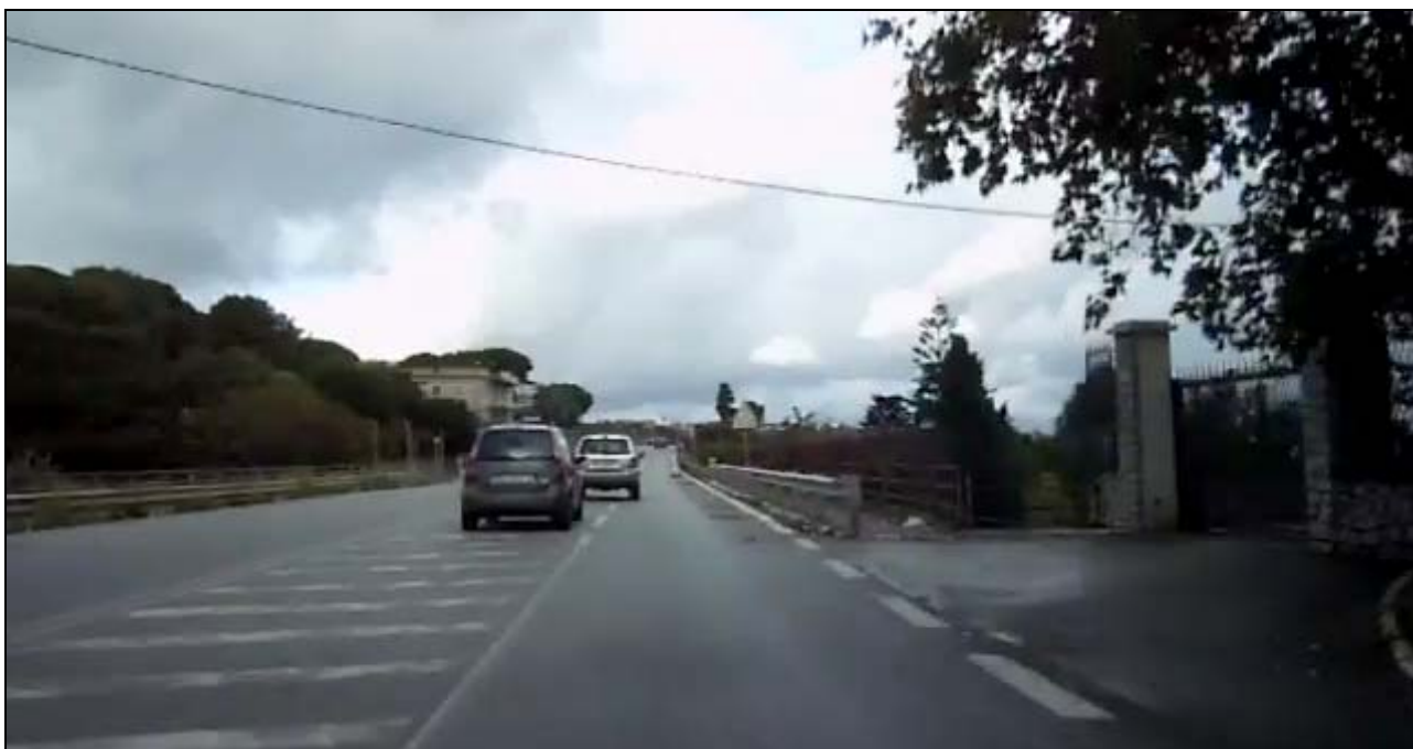
Fotografia 2-38: Strada Panoramica dello Stretto (Arco V-SE1c). Carreggiata Nord in prossimità dell'intersezione con la SP45 Salita Faro Superiore. Si nota la restrizione della carreggiata che non presenta spartitraffico. La corsia di sinistra lascia posto ad una zebra cui segue la canalizzazione per la svolta a sinistra sulla SP45.
