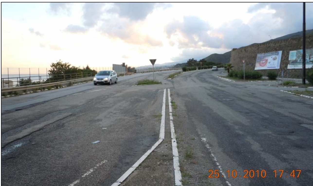
Fotografia 2-29: Strada Panoramica dello Stretto (Arco V-SE1d) – intersezione con Via Fiumara Guardia (Arco V-SA2) (vista in direzione Messina delle canalizzazioni sulla Panoramica)
