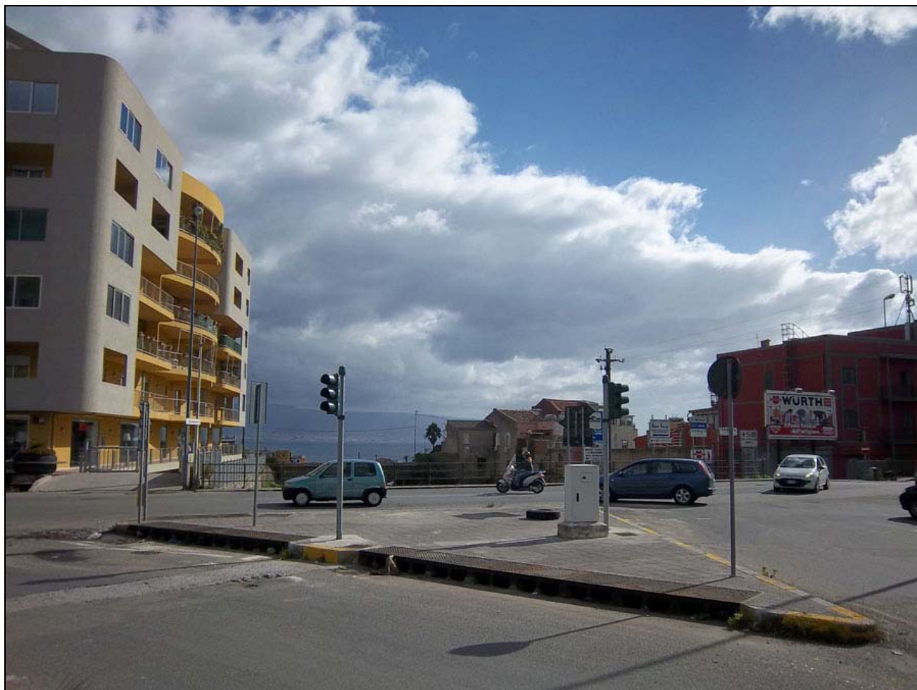
Fotografia 2-4: Incrocio tra le rampe dello svincolo autostradale San Filippo (Arco V-SE9) e la SS 114 (sullo sfondo il punto in cui l'arco di nuova realizzazione V-SN3 intersecherà la SS114)
