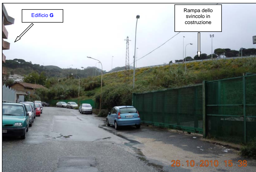
Fotografia 4-9 – Cannello in corrispondenza dell'accesso all'area di cantiere (sospeso) che va spostato
