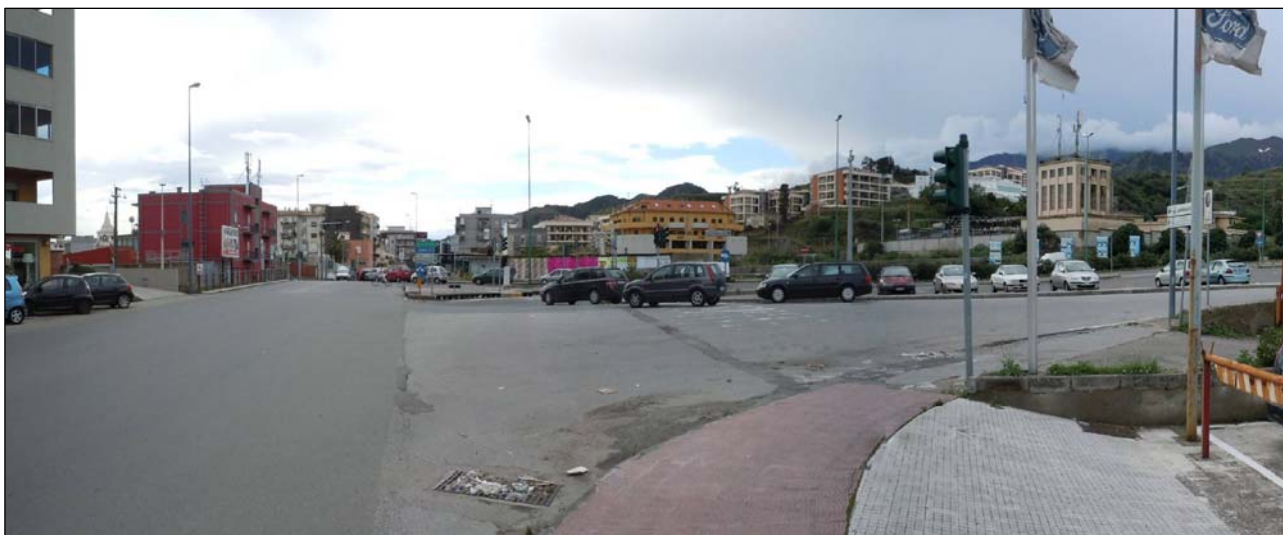
Fotografia 2-1: Incrocio tra le rampe dello svincolo autostradale San Filippo (Arco V-SE9) e la SS 114 (Vista della SS114 in direzione SUD)
