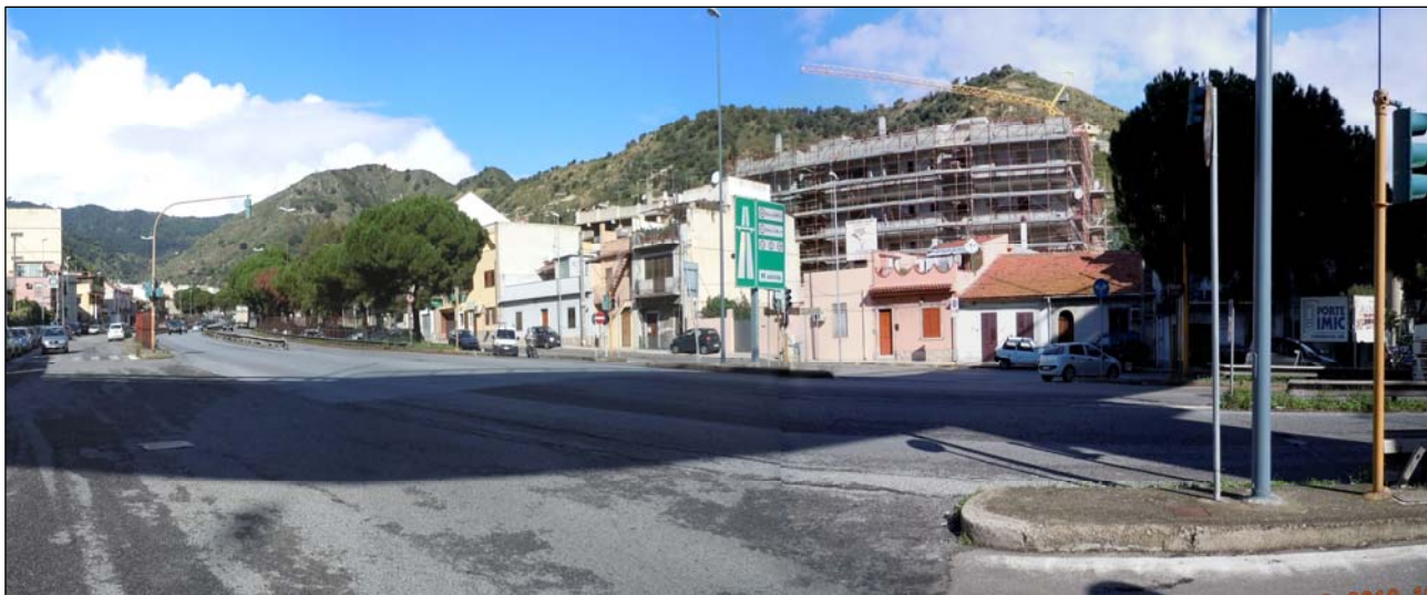
Fotografia 2-5: Via Camaro (Arco V-SE8) – intersezione tra l’asse principale e le controstrade di Via Camaro in prossimità dell’inizio delle rampe dello svincolo autostradale di Messina Centro (vista in direzione Autostrade).
