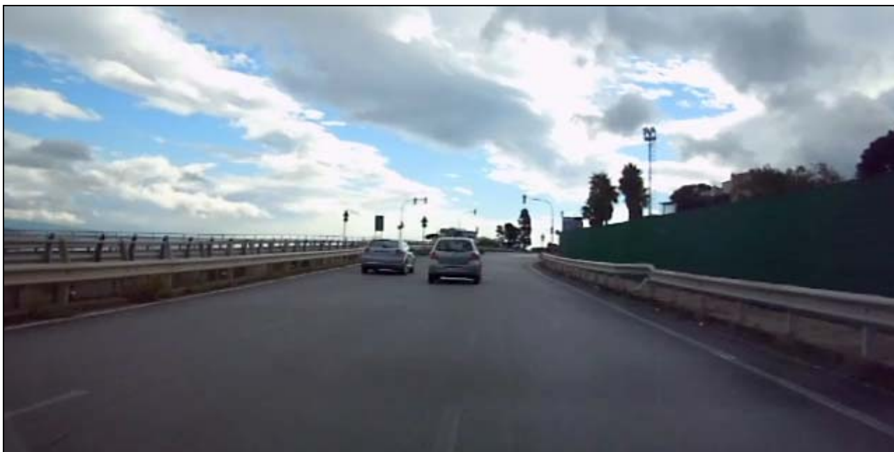
Fotografia 2-37: Strada Panoramica dello Stretto (Arco V-SE1c). Carreggiata Sud in prossimità del collegamento con la località di Faro Superiore.
