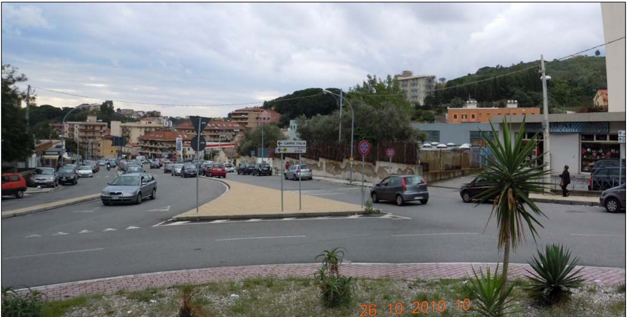
Fotografia 2-14: Piazza E. Verzera - intersezione tra Via Palatucci (Arco V-SE7b), Viale Annunziata (Arco V-SE6a) e Via Campo Italia (Arco V-SE6b) (vista in direzione di Viale Annunziata)
