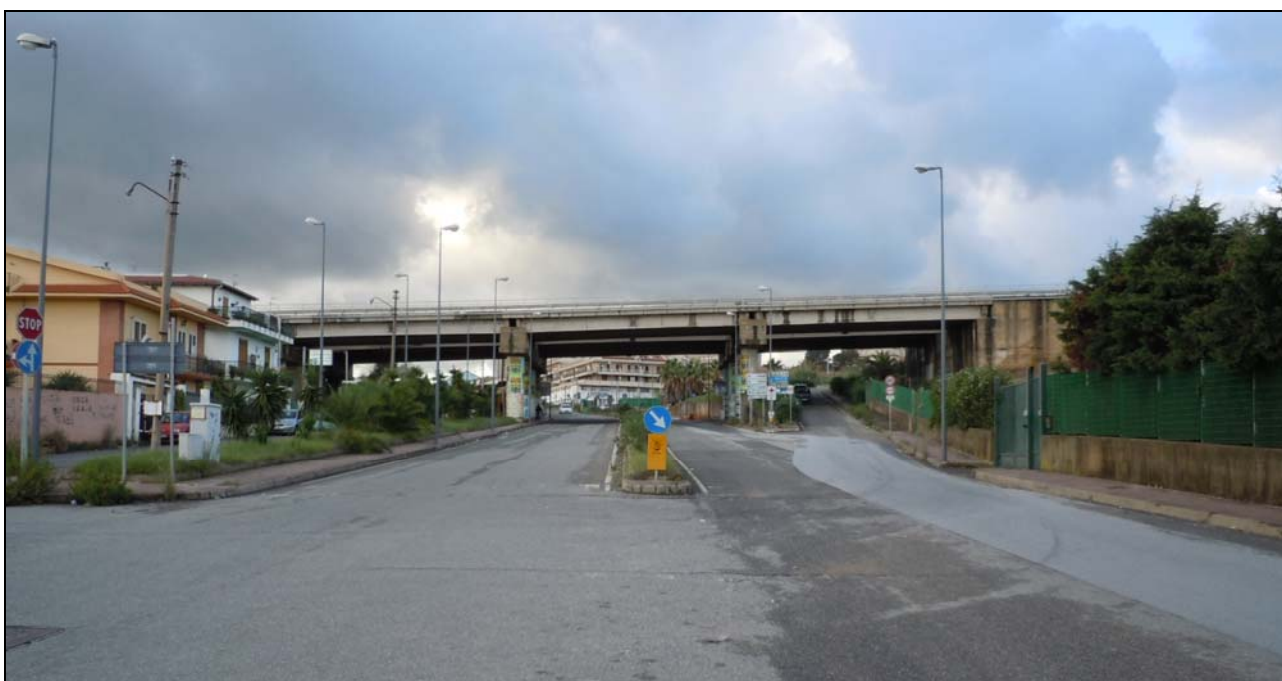
Fotografia 2-32: Salita Papardo. All'estrema destra la rampa per imboccare la strada Panoramica dello Stretto in direzione Messina (Arco V-SE3c). Al centro le due carreggiate di Salita Papardo: la carreggiata in salita è il secondo tratto dell'Arco V-SE3.a (percorso dai mezzi diretti al cantiere SS1).
