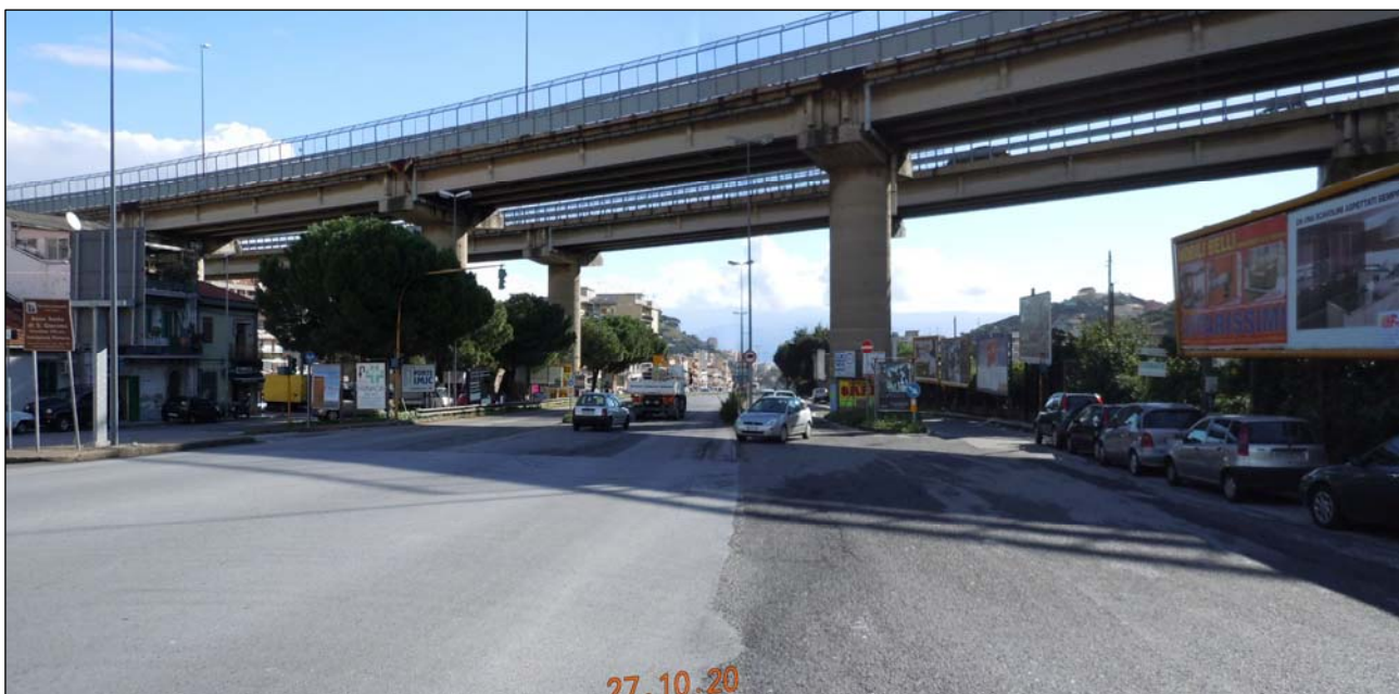
Fotografia 2-6: Via Camaro (Arco V-SE8). Intersezione tra l’asse principale e le controstrade di Via Camaro in prossimità dell’inizio delle rampe dello svincolo autostradale di Messina Centro (vista in direzione centro città)
