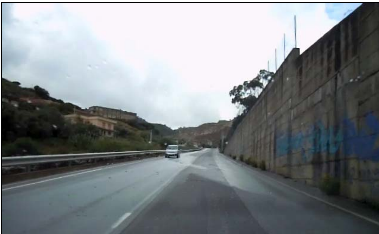
Fotografia 2-21: Via Fiumara Pace (Arco V-SE5) – Sezione trasversale; vista in direzione delle aree di cantiere
