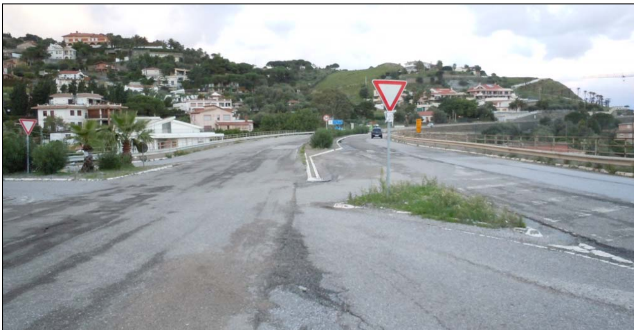
Fotografia 2-28: Strada Panoramica dello Stretto (Arco V-SE1d) – intersezione con Via Fiumara Guardia (Arco V-SA2) (vista in direzione Ganzirri delle canalizzazioni sulla Panoramica)
