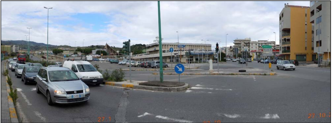
Fotografia 2-3: Incrocio tra le rampe dello svincolo autostradale San Filippo (Arco V-SE9) e la SS 114 (Vista della SS114 in direzione NORD)
