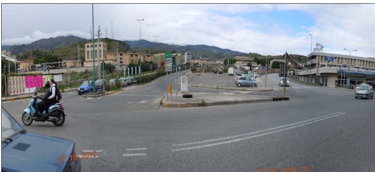
Fotografia 2-2: Incrocio tra le rampe dello svincolo autostradale San Filippo (Arco V-SE9) e la SS 114 (Vista in direzione delle rampe dello svincolo autostradale)
