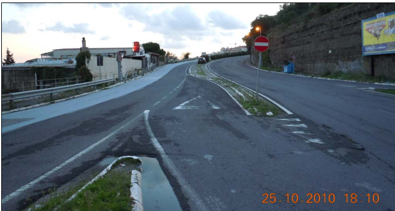
Fotografia 2-24: Strada Panoramica dello Stretto (Arco V-SE1d) – intersezione con Via Fiumara Pace (Arco V-SE5) (vista delle canalizzazioni in direzione Messina Centro)
