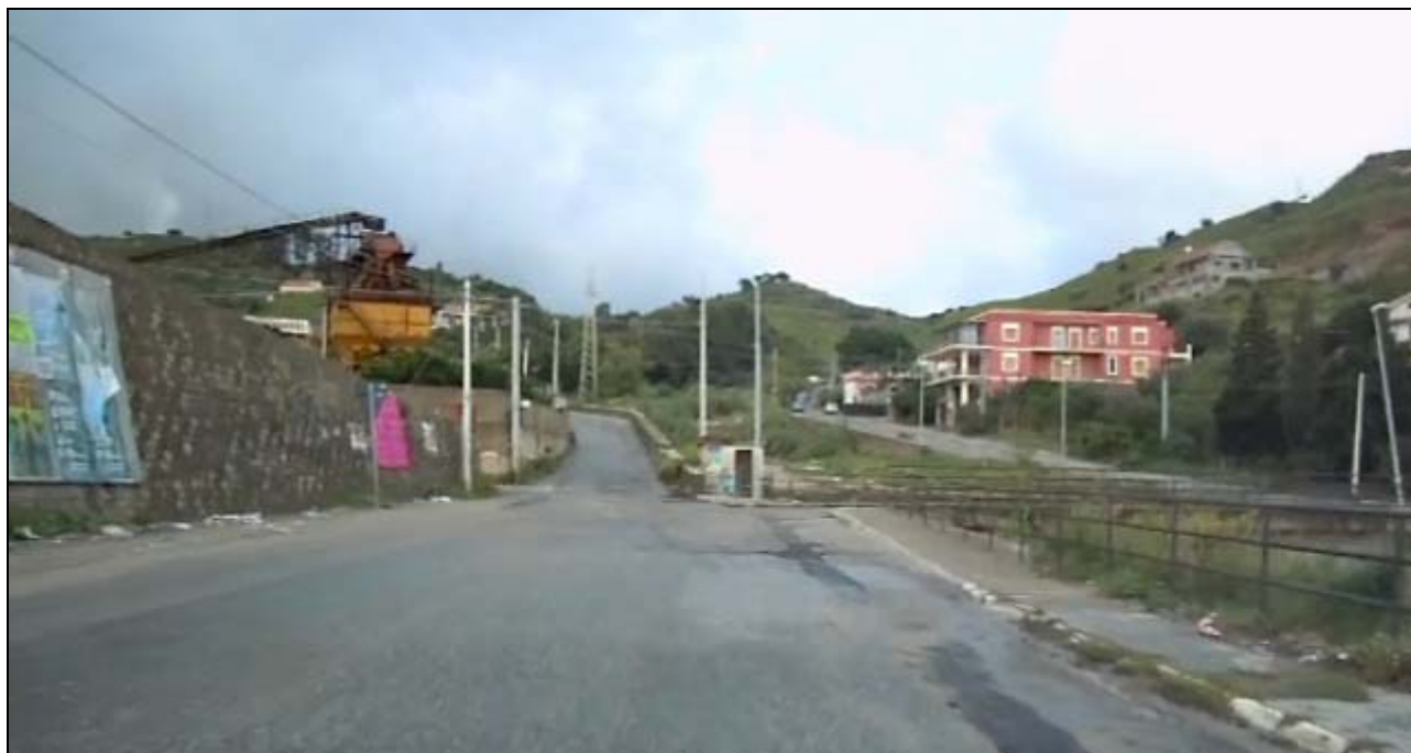
Fotografia 2-25: Via Fiumara Guardia (Arco V-SA2) – tratto iniziale. Sulla destra è visibile la diramazione da Via Fiumara Guardia (Arco V-SE4) per l'area di Cantiere SI3 e per l'area di deposito SRA2.
