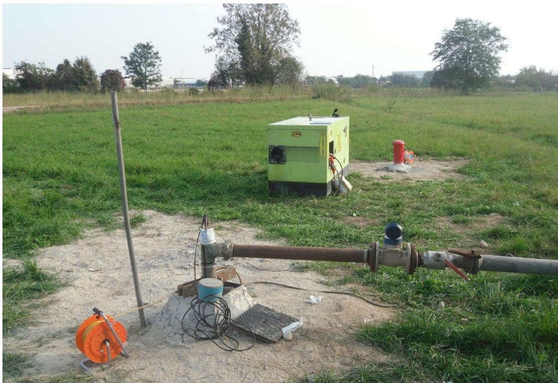
Figura 15 – Campo prova nord. In primo piano il pozzo attrezzato, in secondo piano il piezometro di monitoraggio. Entrambe le opere sono state attrezzate con strumenti di rilevazione automatica e manuale.
