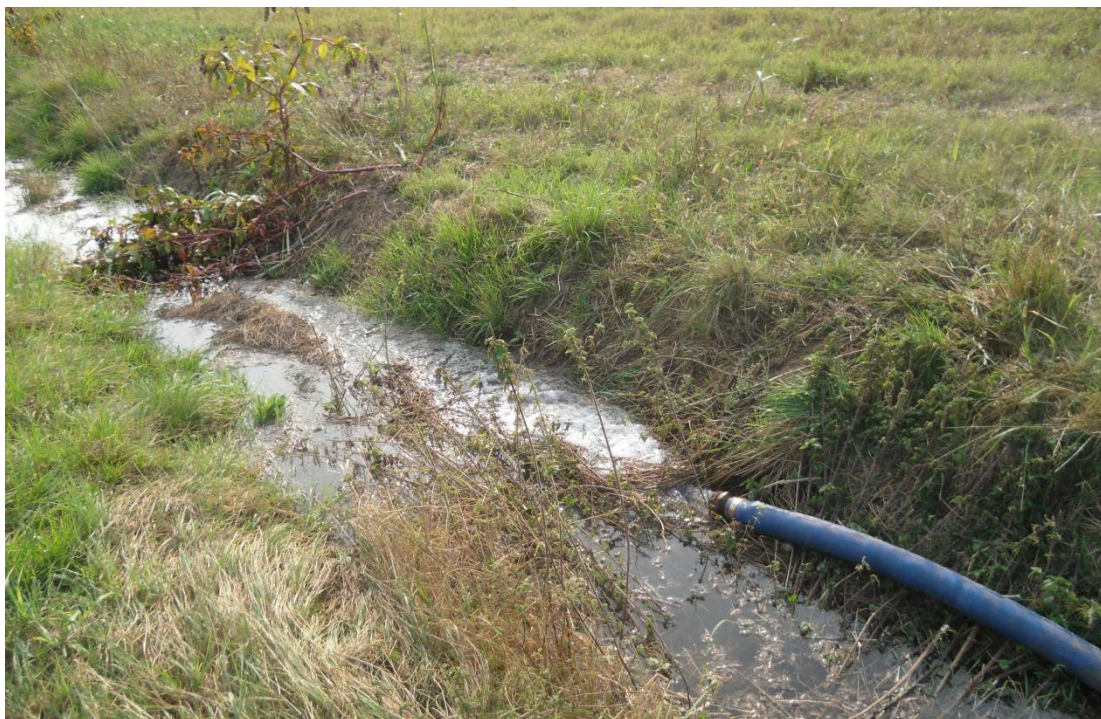
Figura 16 – Scarico delle acque emunte in adacquatrice privata.
