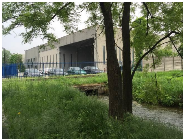
Figura 7-2 - Canale Adduttore A fine tratto tombinato e inizio alveo naturale
