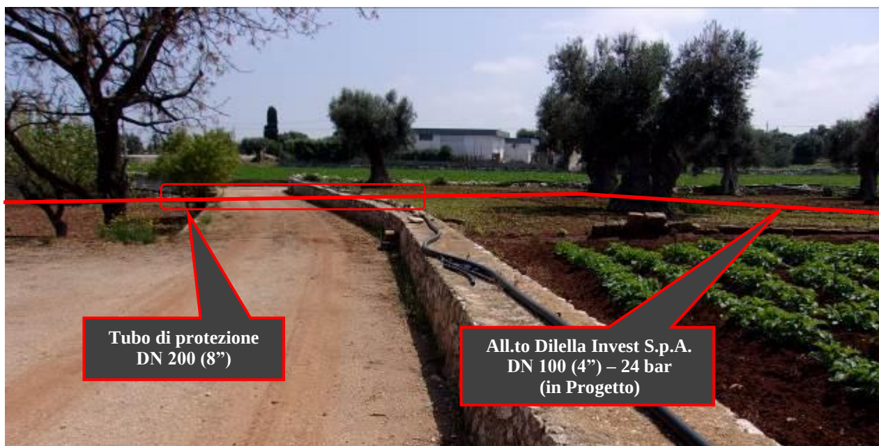
Foto 5 – Attraversamento strada privata asfaltata
