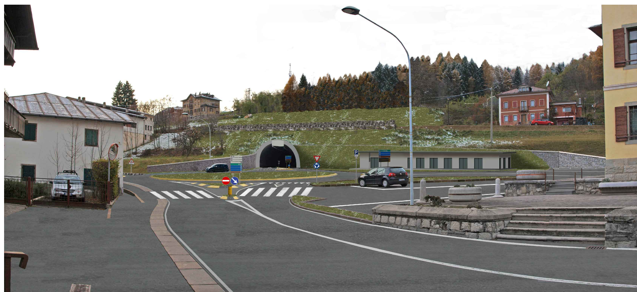
Locale tecnologico con a tergo scarpata rinverdita
