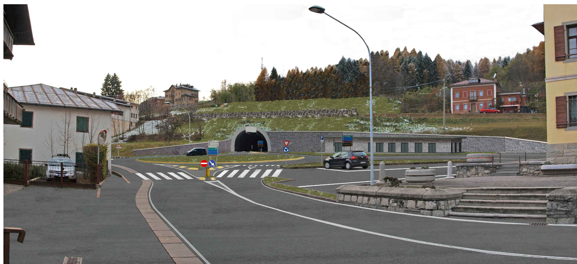
Locale tecnologico rivestito con massi
