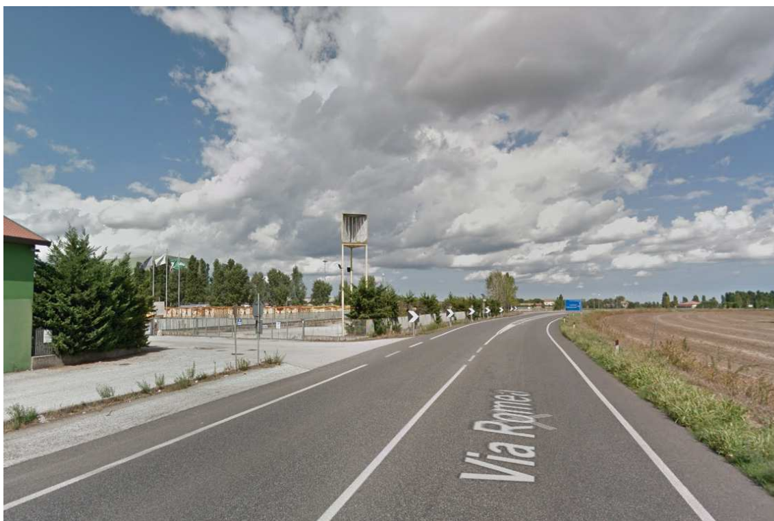
FOTO 4 – Intervento 18 – Accesso diretto da dismettere
