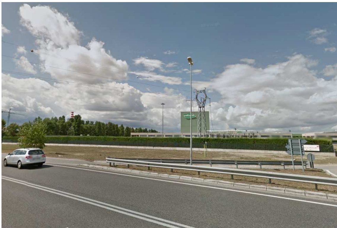
FOTO 6 – Intervento 18 – Area individuata per il cantiere di base
