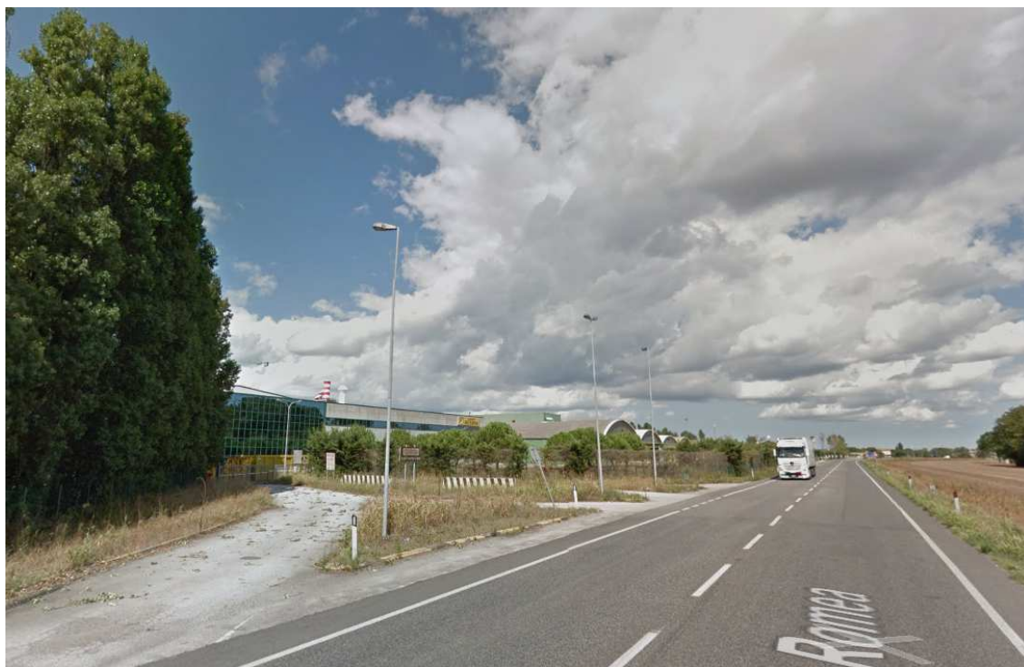
FOTO 5 – Intervento 18 - Accesso diretto da dismettere 500 m a sud della Rotatoria
