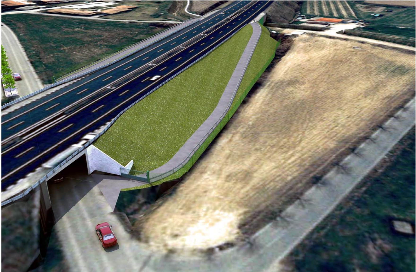
Foto n.1 – rampa in salita
