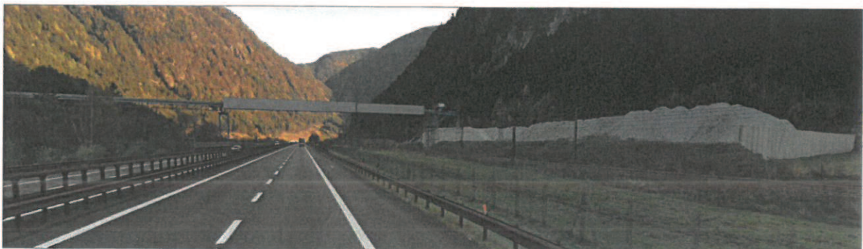
Nastro trasportatore di collegamento tra i cantieri di Mules e Genauen (sulla destra nell'immagine)
