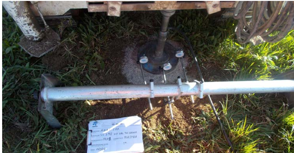
Prova di carico su piastra PZA 1
