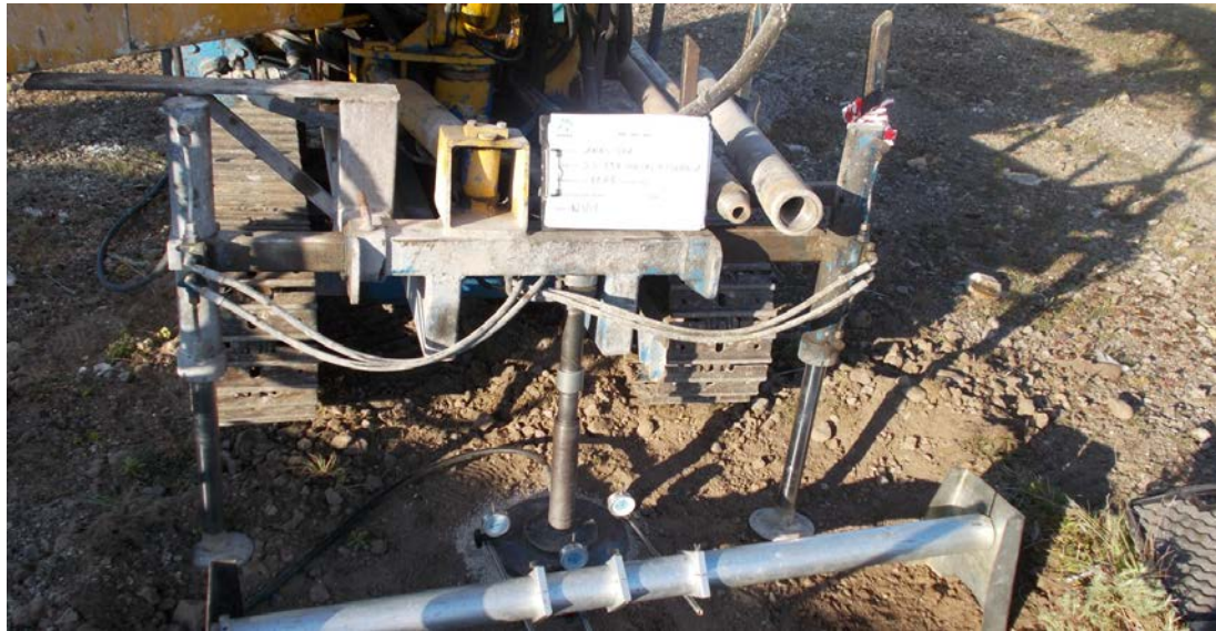
Prova di carico su piastra PZA 5
