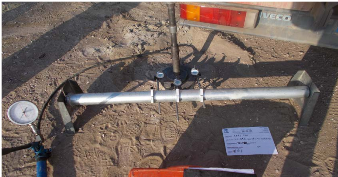
Prova di carico su piastra PZA 10
