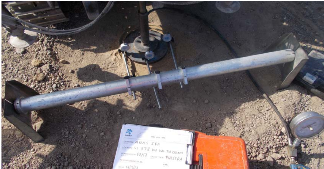
Prova di carico su piastra PZA 7
