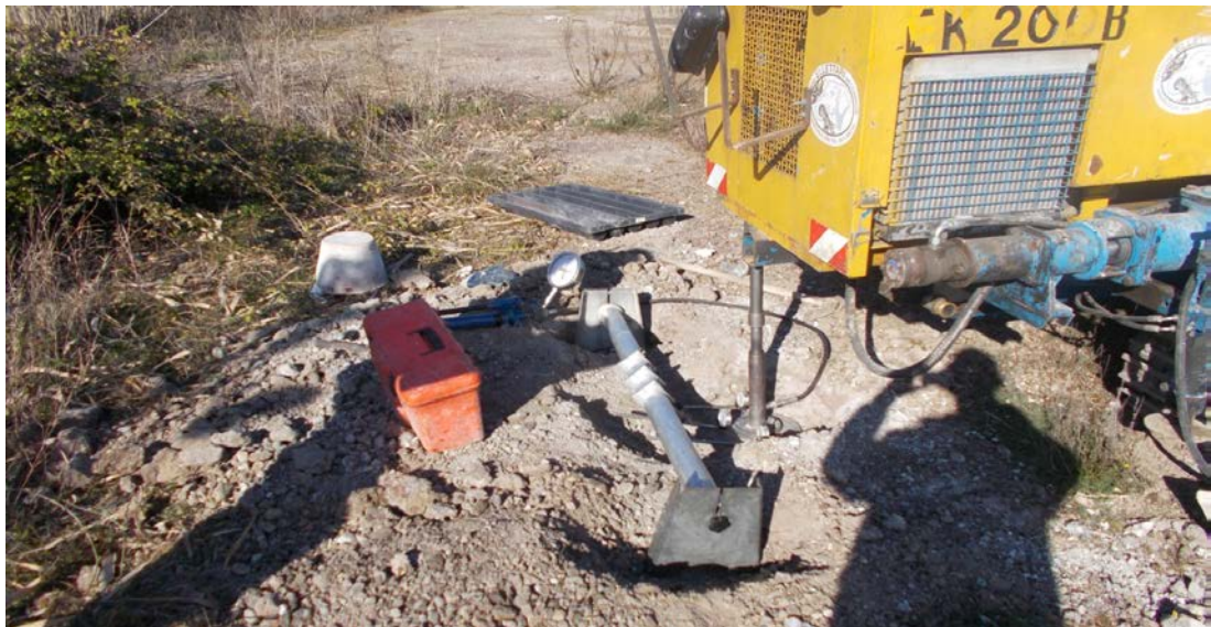
Prova di carico su piastra PZA 6
