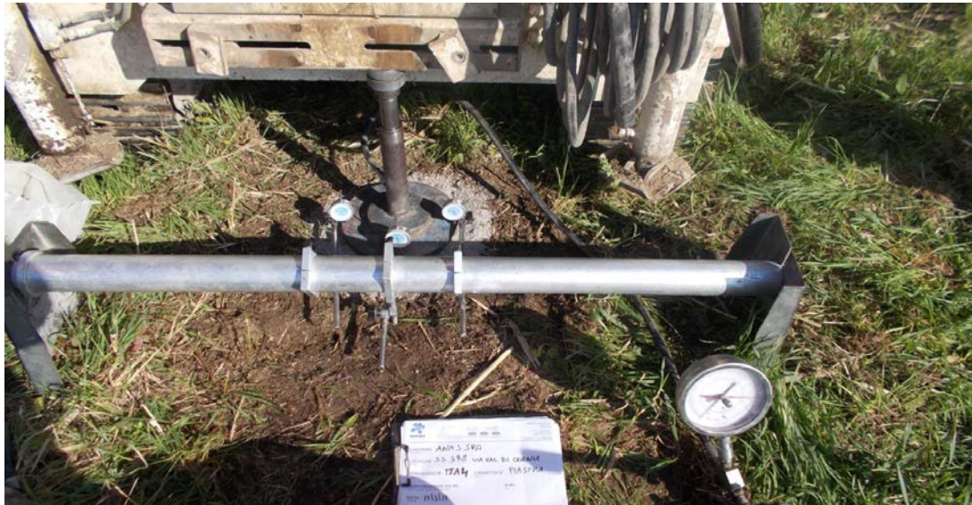
Prova di carico su piastra PZA 4
