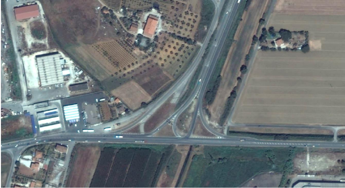
Fig.13 – Stato attuale intersezione
