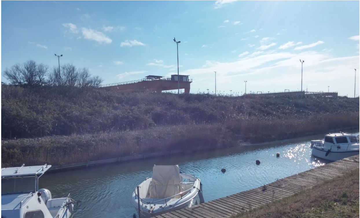
Fig.5 – Tratto canale "Vecchia Cornia" esistente
