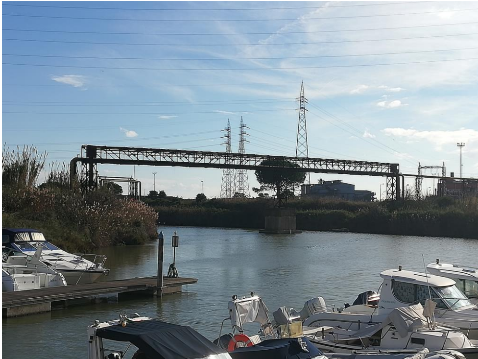
Figura 2 - Ponte tubo da demolire
