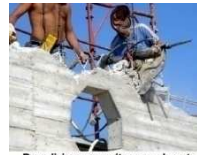
Demolizione eseguita manualmente
