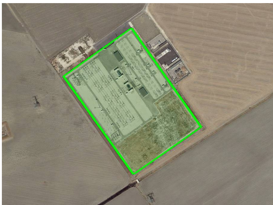
Stazione Terna – Loc. "Macchia Rotonda"
