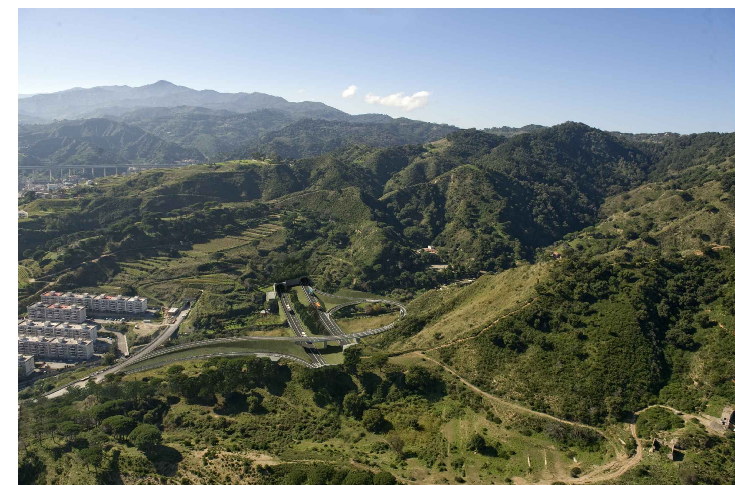
FOTONERIMENTO - SISTEMAZIONE FINALE DELL'AREA DI CANTIERE
