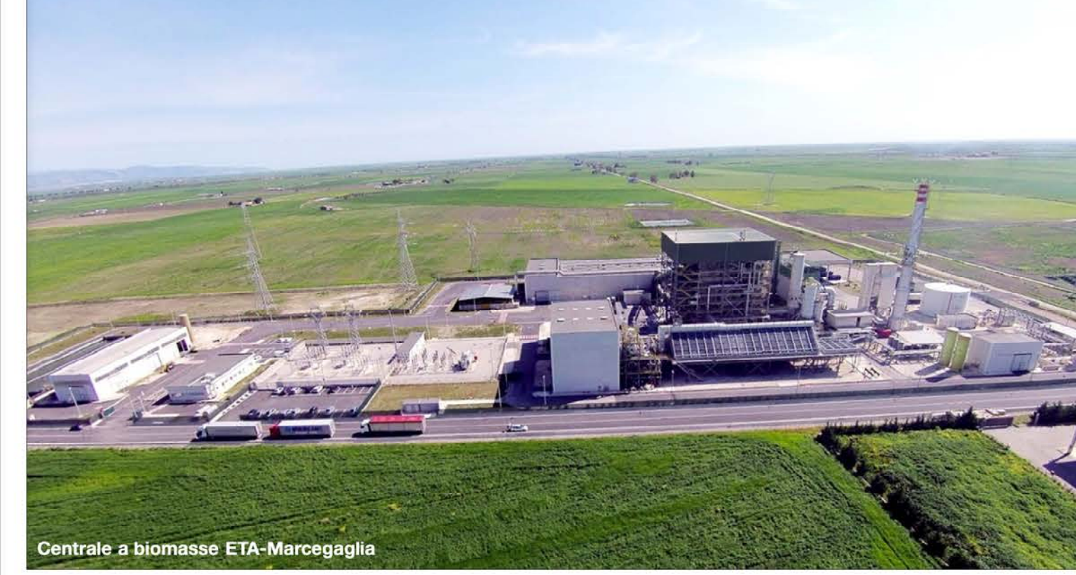
Centrale a biomasse ETA-Marcegaglia
