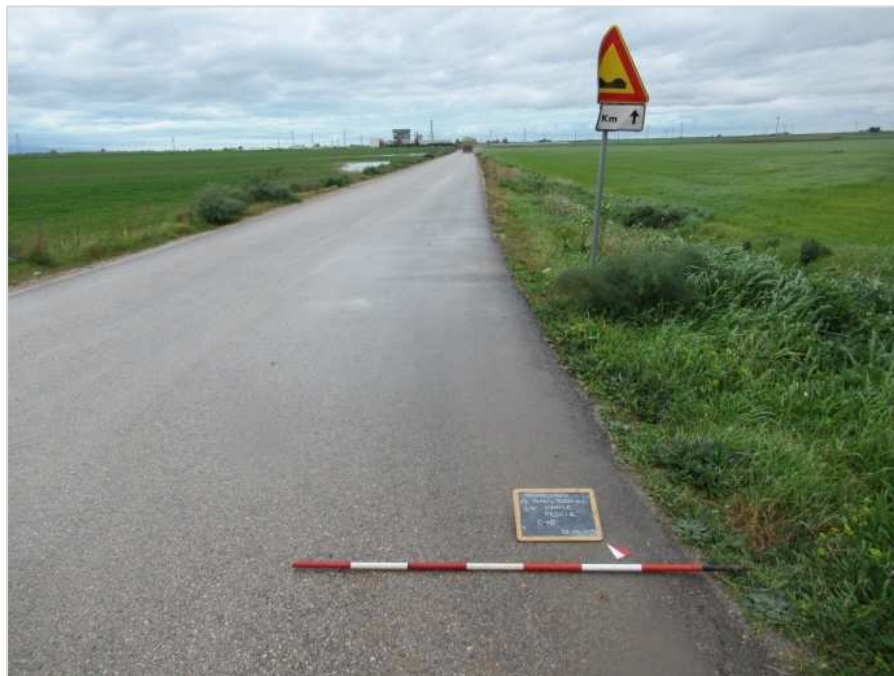
Figura 1: CVD tra gli aerogeneratori 10-24, visto da SE
