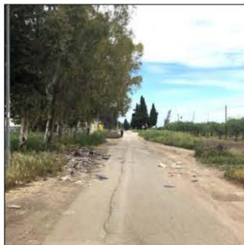
pavimentazione in conglomerato bituminoso in pessimo stato
