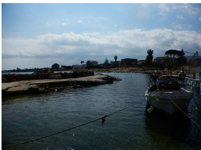
Fig. 3.4: Vista di insieme delle condizioni del braccio di sopraflutto, Si osservi il cedimento di un buon tratto del filo esterno della banchina posta sul braccio di sopraflutto.
