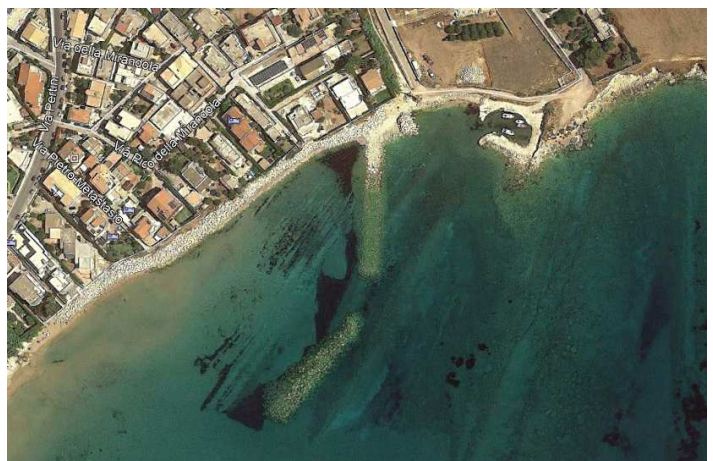
Figura 2.3.b: Ortofoto anno 2017 con eseguiti i lavori di difesa costiera di 1° stralcio ed in corso di ultimazione i lavori di difesa costiera di 2° stralcio
