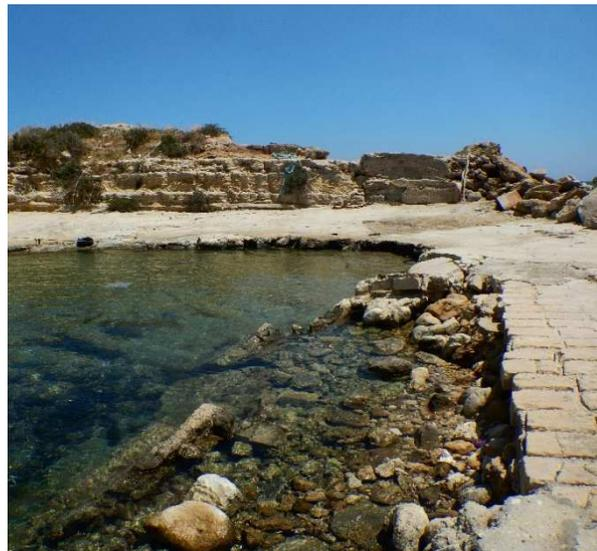
*Figura 4: Stato di deterioramento della struttura di banchina*
