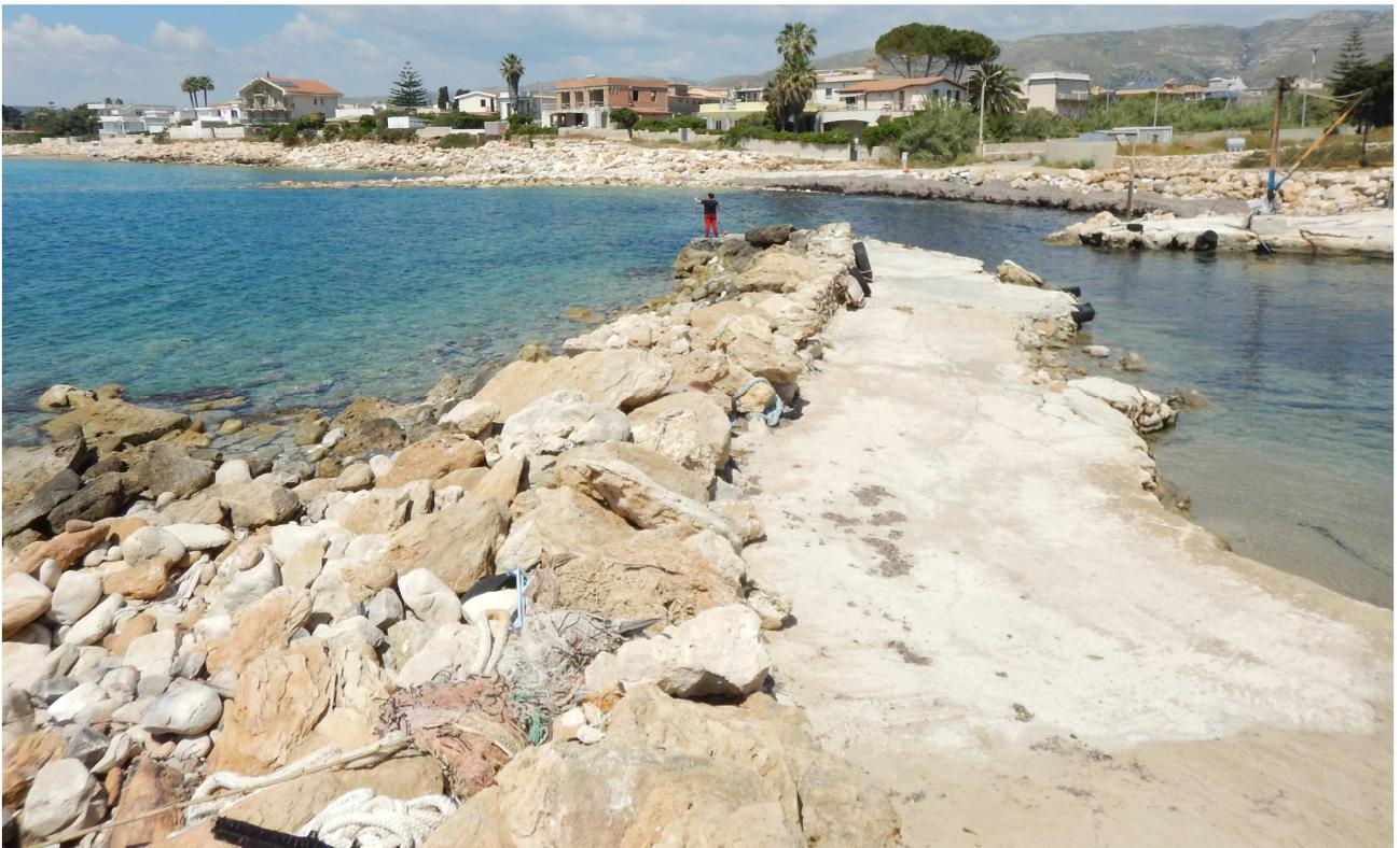
*Figura 7: Massi naturali a protezione del bacino interno*
