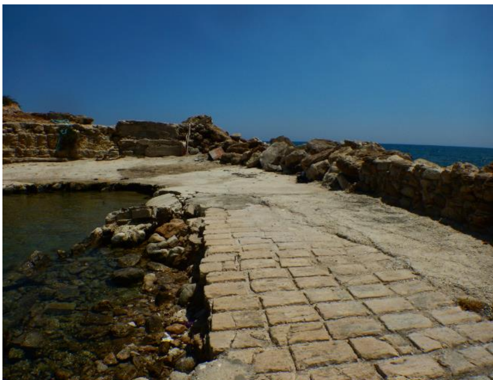
Fig.1C- Particolare della banchina esistente sul braccio di sopraflutto.
