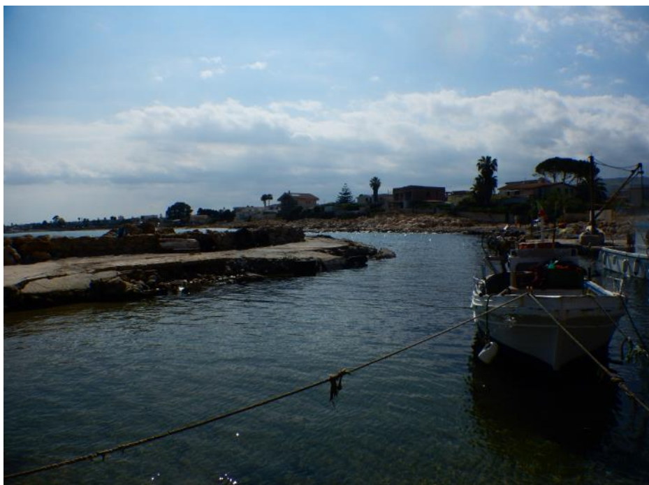
Fig.1D- Vista di insieme delle condizioni del braccio di sopraflutto
