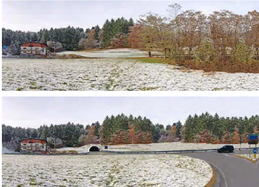
Figura 21 Area di intervento imbocco Est: foto della situazione attuale e foto con inserimento del progetto con imbocco della galleria a lato del "Bar Bianco"
