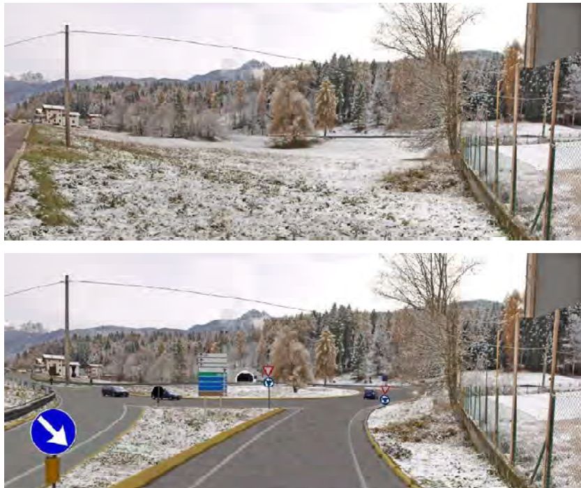
Figura 22 Area di intervento imbocco Ovest: foto della situazione attuale e foto con inserimento del progetto
