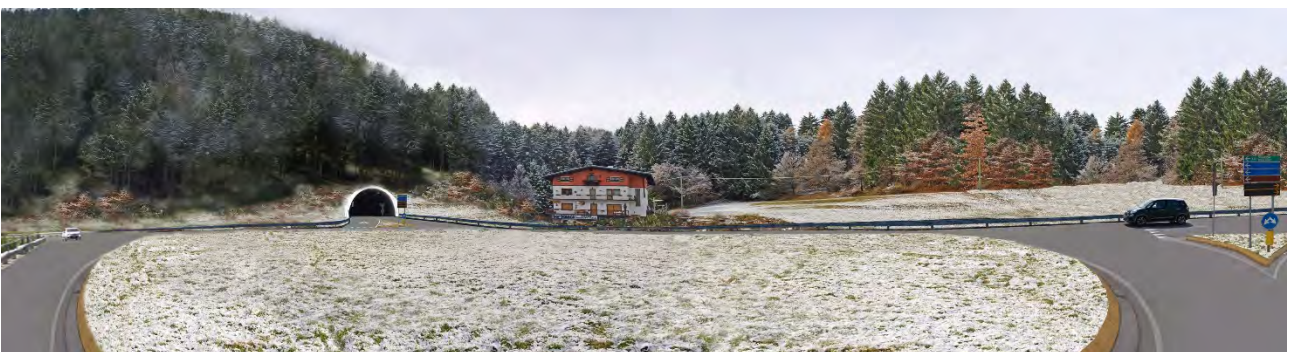
Figura 25 Progetto di variante; Area di intervento imbocco Est;: foto della situazione attuale e foto con inserimento del progetto con imbocco della galleria posto a valle e arretrato rispetto all'edificio che ospita il "Bar Bianco"
