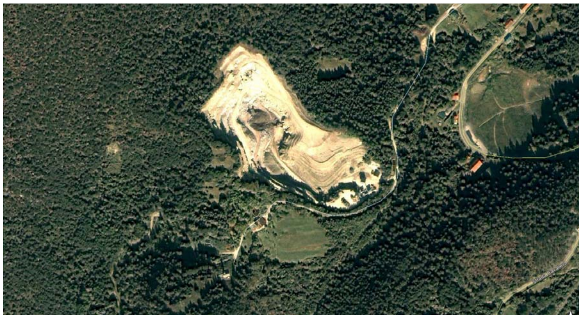
Figura 9 – Particolare deposito definitivo (Cava Damos) su ortofoto
