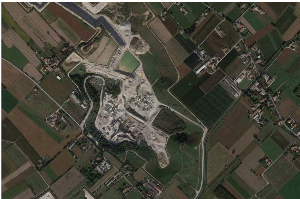
Figura 13 - Particolare deposito definitivo (Superbeton S.p.a.) su ortofoto
